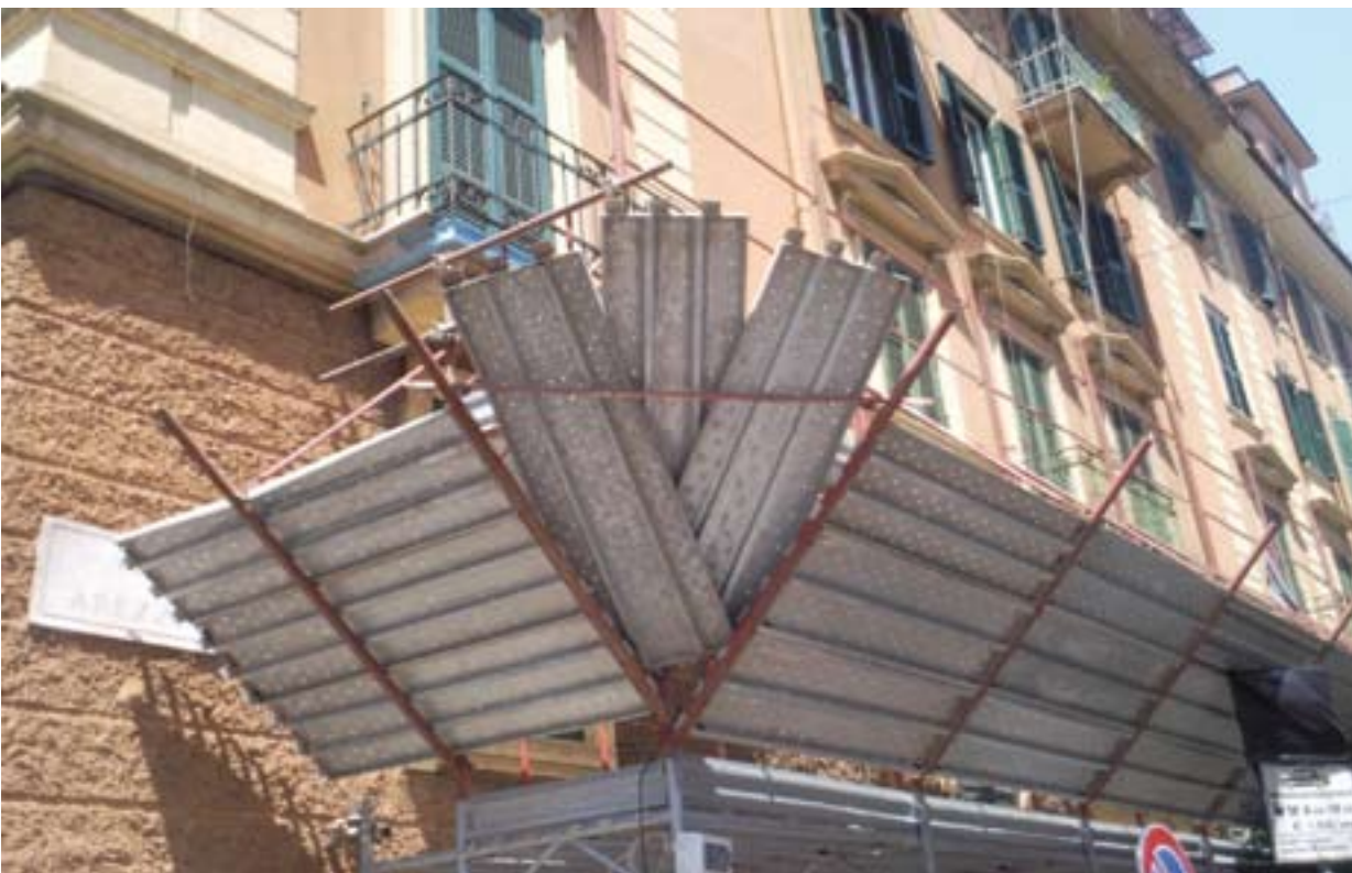
Fig. 4.3.8: Soluzione d'angolo della mantovana realizzata con tavole metalliche.
