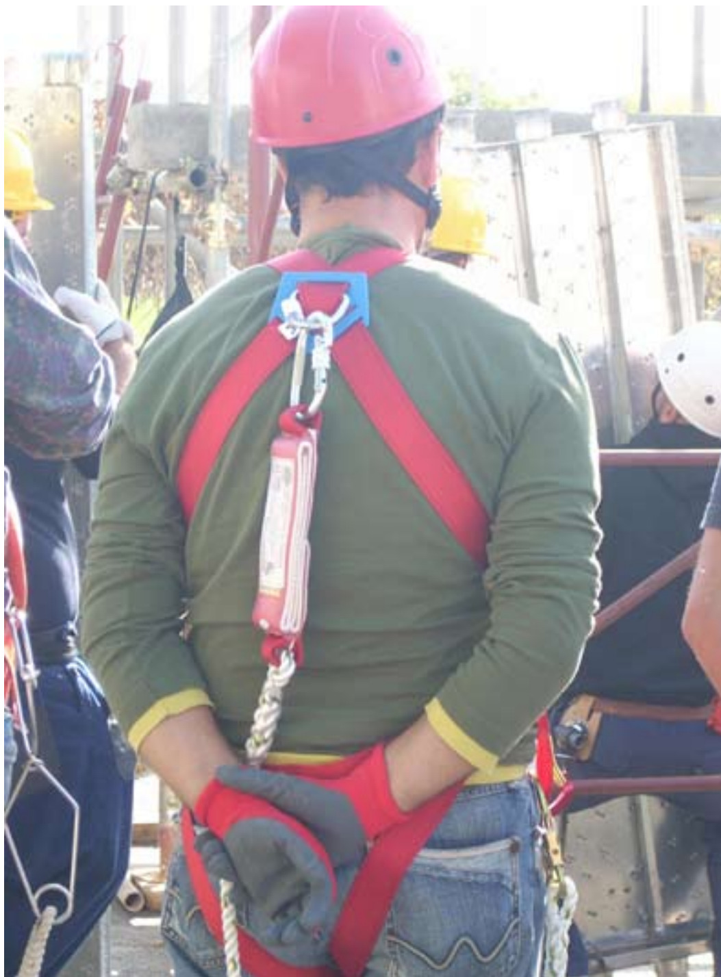
Fig. 6.2.10: Dispositivo anticaduta con dissipatore di energia UNI EN 355.
