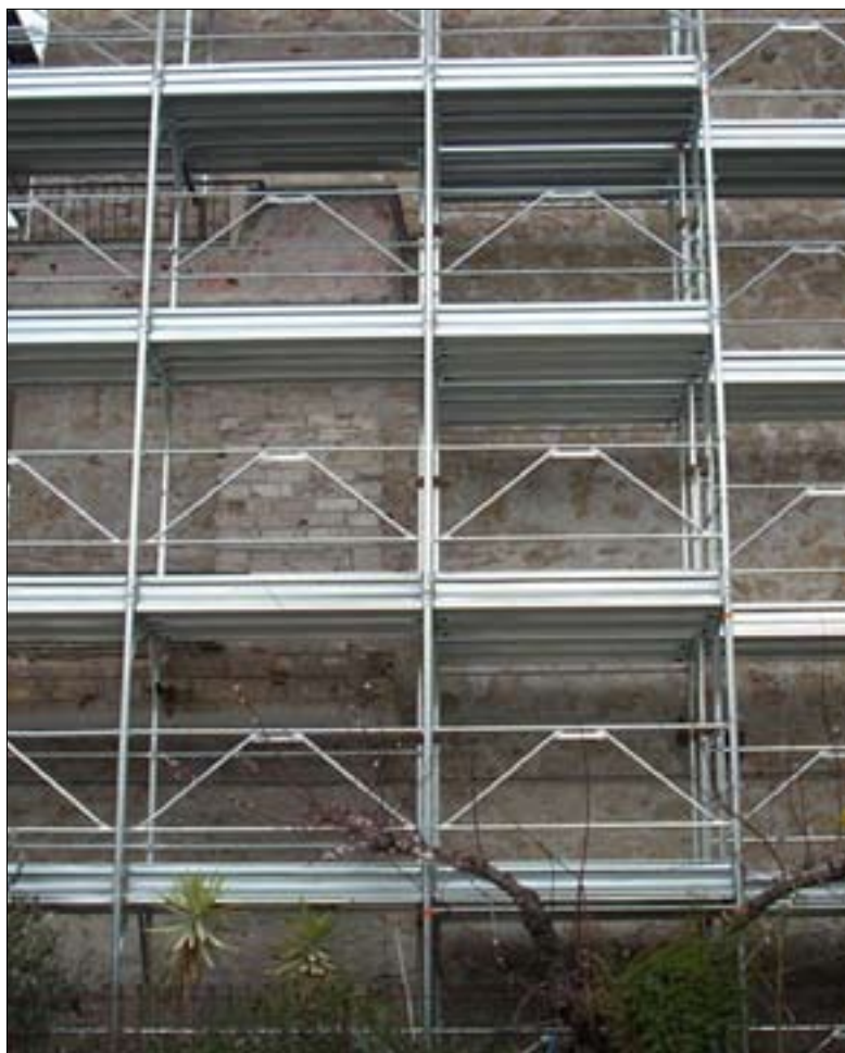
Fig 1.3.2: Telaietto prefabbricato che svolge la funzione sia di parapetto che di irrigidimento del piano verticale.
