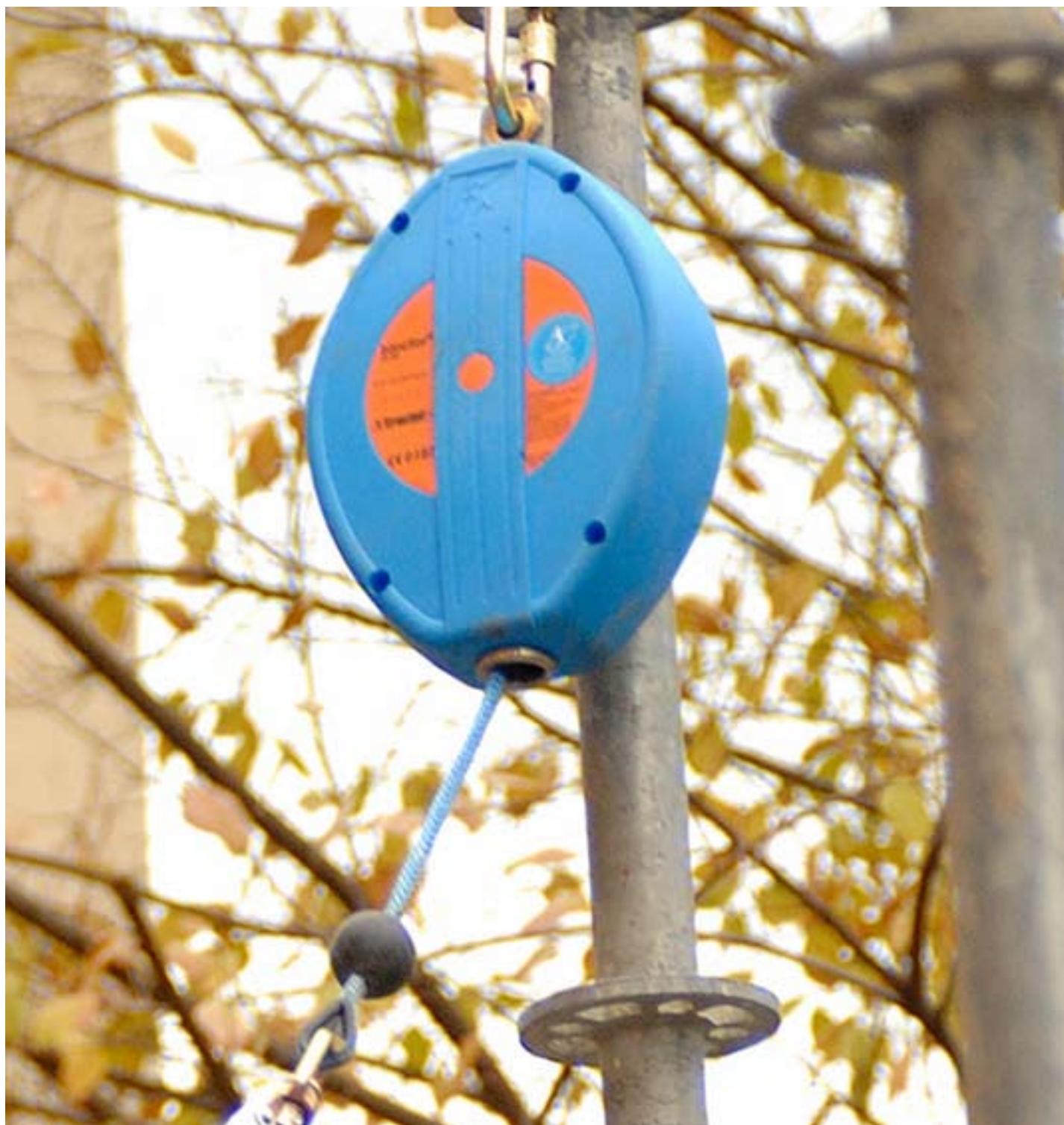
Fig. 6.2.12: Dispositivo di protezione individuale retrattile con cordino in fibra tessile.
