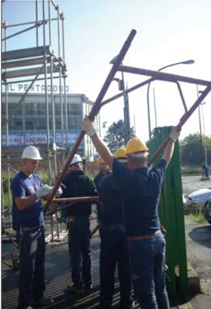
Figg. 2.3.19 - 2.3.20: Metodo dei telai sovrapposti per l'esecuzione del montaggio di punta.
