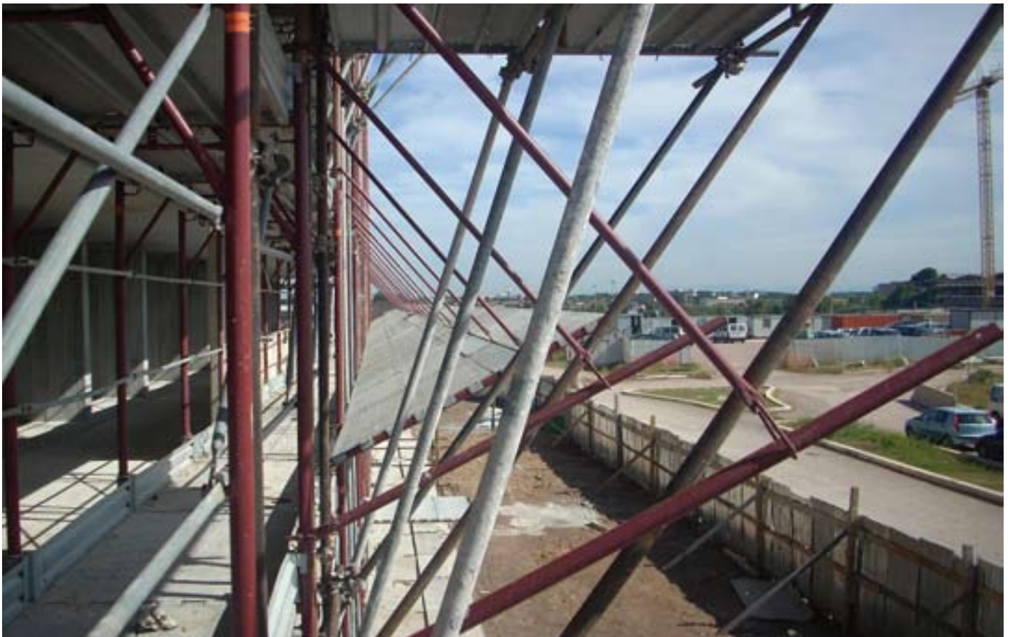
Fig. 4.3.4: Elemento prefabbricato per mantovana formato da tirante e tubo con aggetto 1,5 m.
