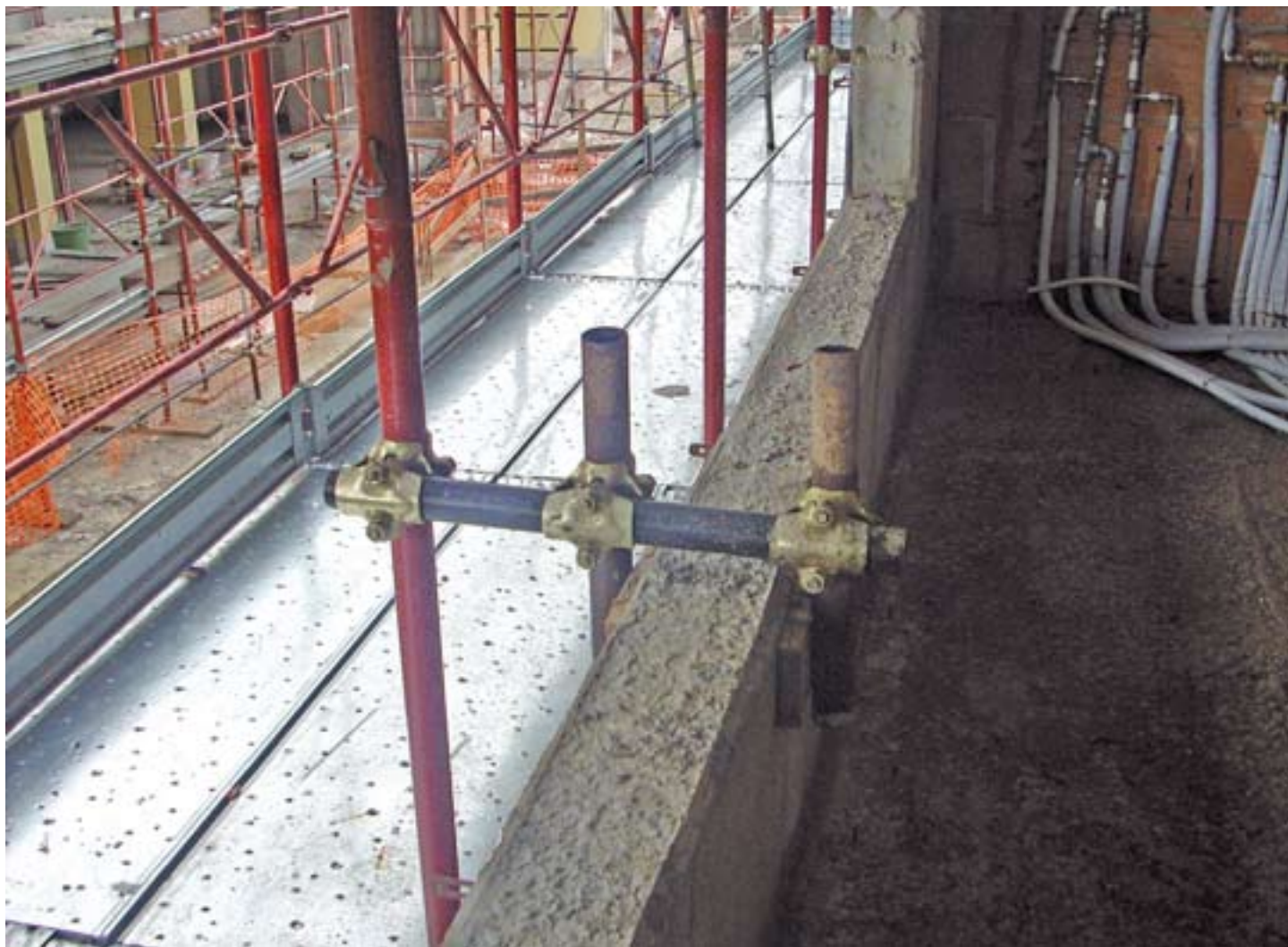
Fig. 4.4.2: Ancoraggio a cravatta realizzato su elementi di parapetto in cemento armato. L'autorizzazione precisa che gli elementi in tubo e giunto utilizzati per la realizzazione dell'ancoraggio devono essere tutti di una unica autorizzazione ministeriale, anche di marca diversa da quella del telaio.
