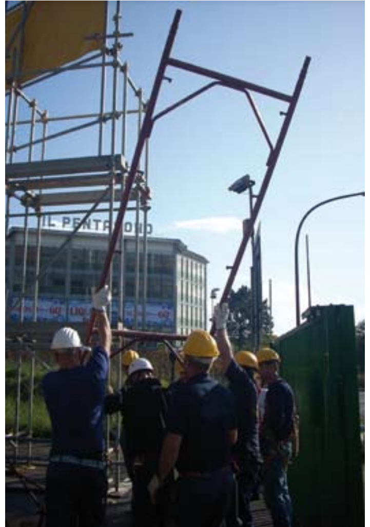
Figg. 2.3.19 - 2.3.20: Metodo dei telai sovrapposti per l'esecuzione del montaggio di punta.
