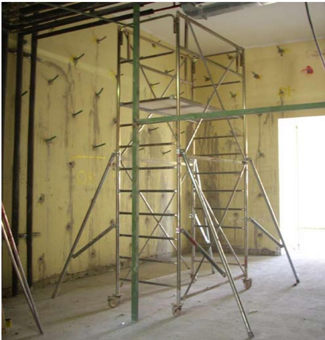
Fig. 5.2: Trabattello conforme alla norma armonizzata UNI HD 1004 che prevede l’uso all’interno fino a 12 m. senza ancoraggio. Le ruote sono frenate e la base è allargata dagli stabilizzatori. A volte la salita è consentita dall’interno sui traversi delle spalle del trabattello.
