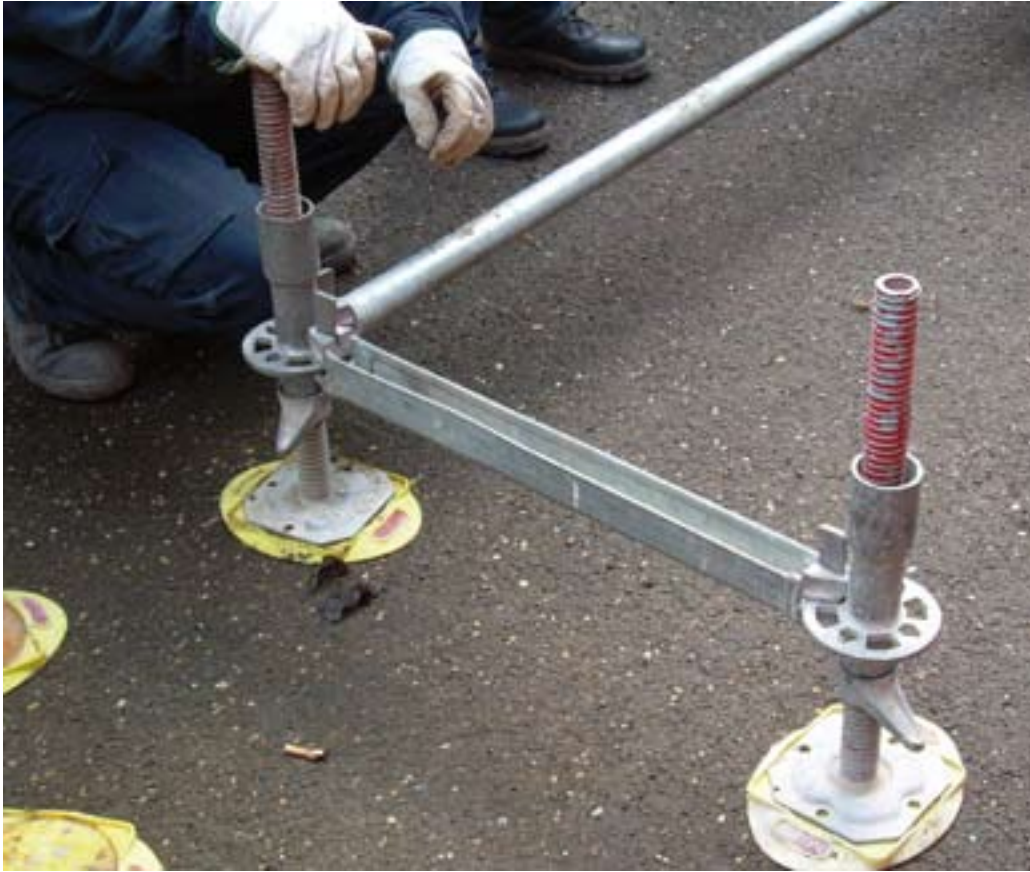
Fig. 2.3.5: Elemento di partenza “bicchiere” per la realizzazione di un piano ad altezza di circa 30 cm.
