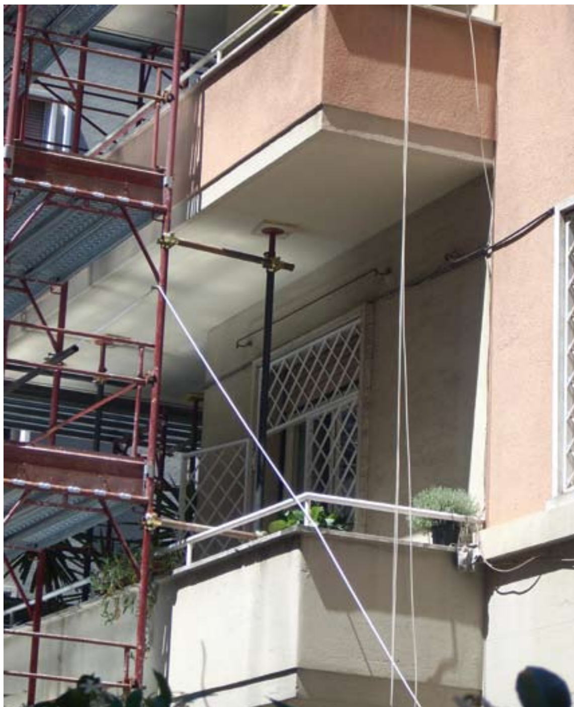
Fig. 4.4.16: Ancoraggio realizzato con montante di ponteggio a tubo e giunto e due basette regolabili a contrasto sui solai. Questo ancoraggio, non essendo previsto dal libretto di autorizzazione ministeriale, non è consentito.
