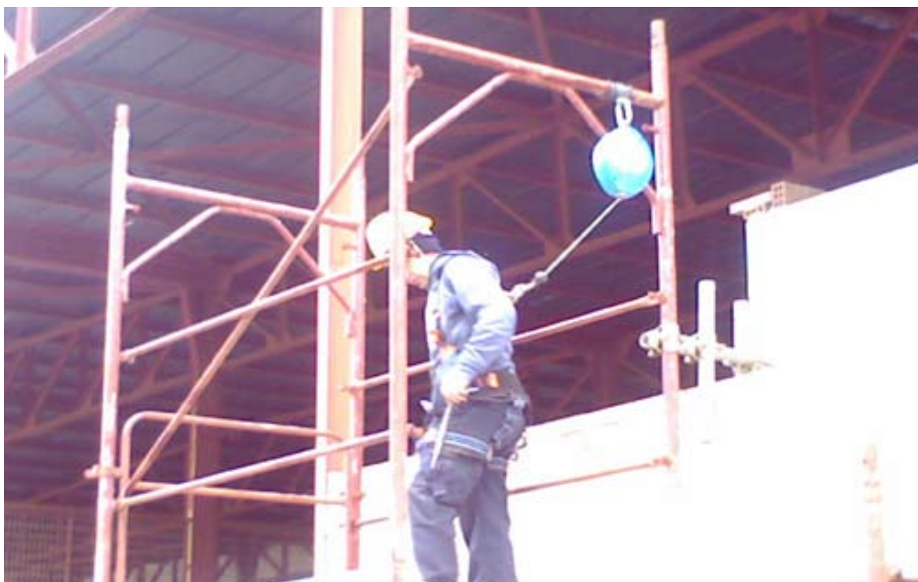
Fig. 6.3.18 : Al dispositivo di ancoraggio tessile UNI EN 795 classe b viene collegato un dispositivo anticaduta retrattile UNI EN 360.
