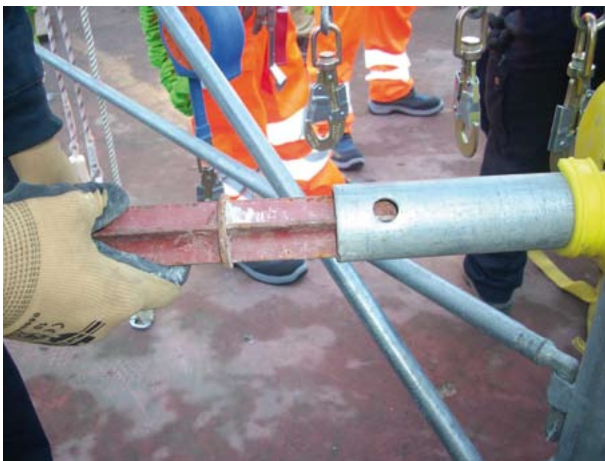
Fig. 2.2.7-2.2.8: Giunto a trazione montato su tubi appositamente predisposti - Inserimento dello spinotto.
