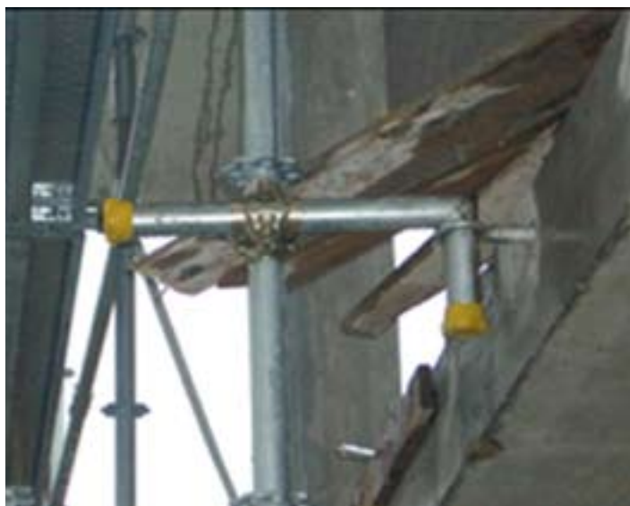
Fig. 4.4.9: Ancoraggio ad "L" autorizzato.
