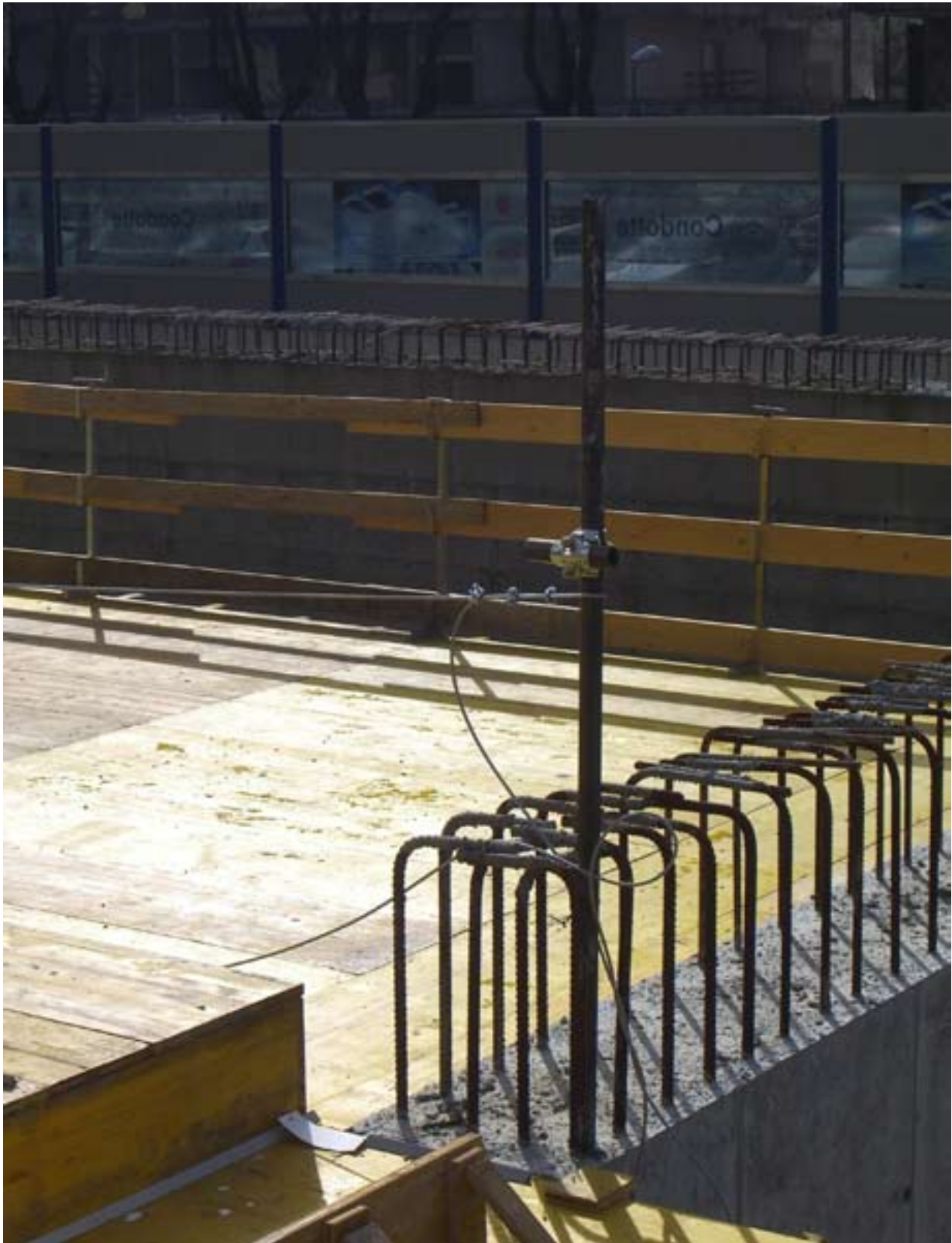
Fig. 6.2.18: Non è consentito realizzare dispositivi di ancoraggio realizzati con funi di acciaio collegate ai montanti e chiuse con morsetti in quanto non conformi alla norma armonizzata UNI EN 795; non è possibile, infatti, certificare le caratteristiche e la resistenza di questa linea vita artigianale né il tirante d'aria in caso di caduta di uno o più lavoratori.
