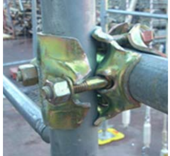
Fig. 2.2.2 Giunto ortogonale.
