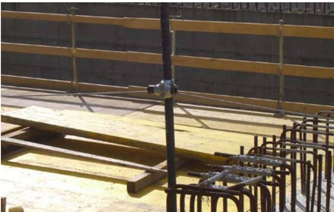
Figg. 6.2.19 - 6.2.20: Particolare dell'ancoraggio della fune al montante con morsetti e di un elemento intermedio di sostegno della fune.
