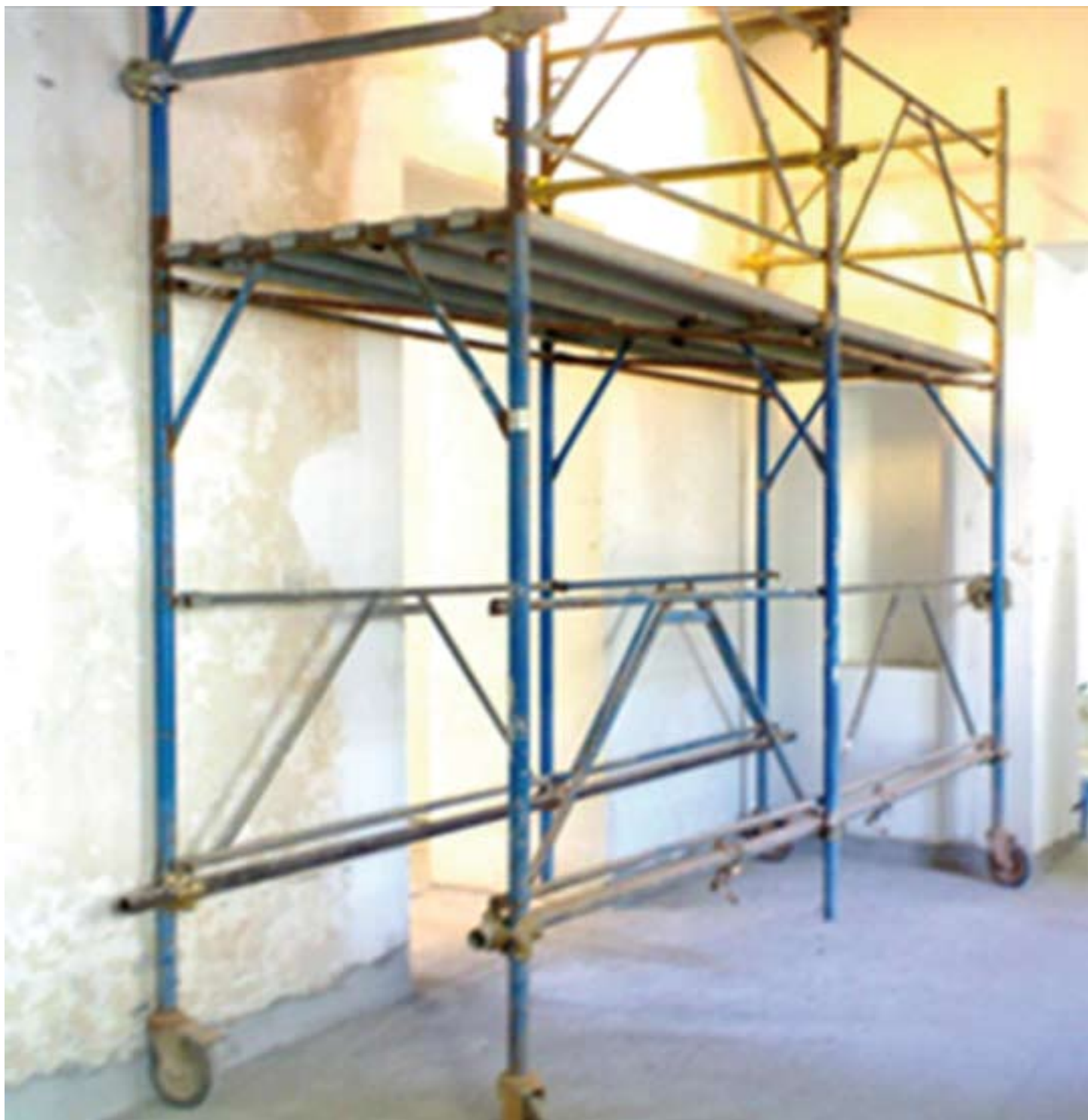
Fig. 5.1: Questa opera provvisoria non è conforme alla normativa in quanto è realizzata con elementi di ponteggio ai quali sono stati applicati le ruote, possibilità non prevista dal libretto di autorizzazione ministeriale. Questa struttura non risponde né alla normativa sui ponteggi, né a quella sui trabattelli.
