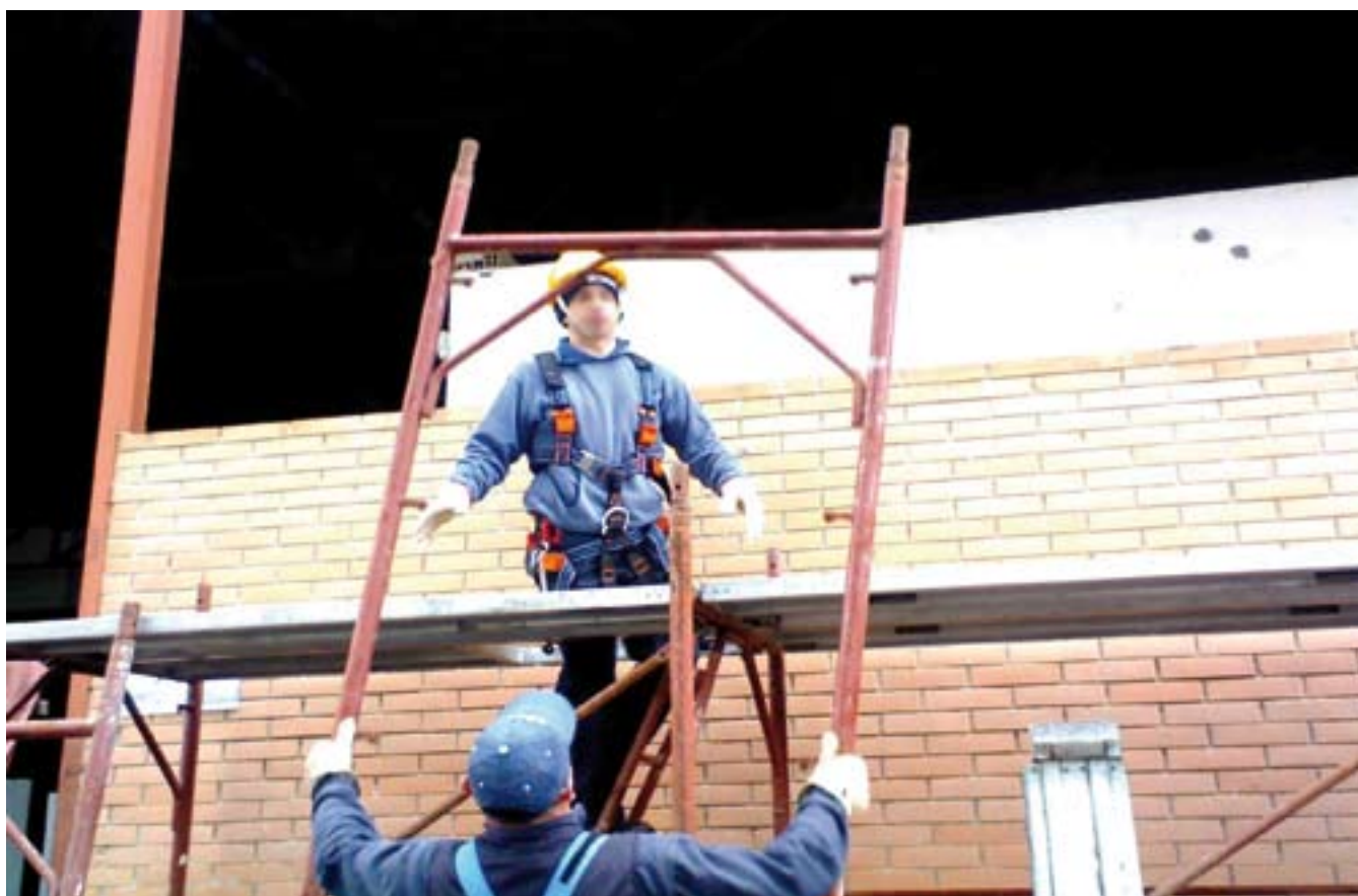
Fig. 6.3.6: Il lavoratore riceve il telaio facendo una leggera torsione del busto
