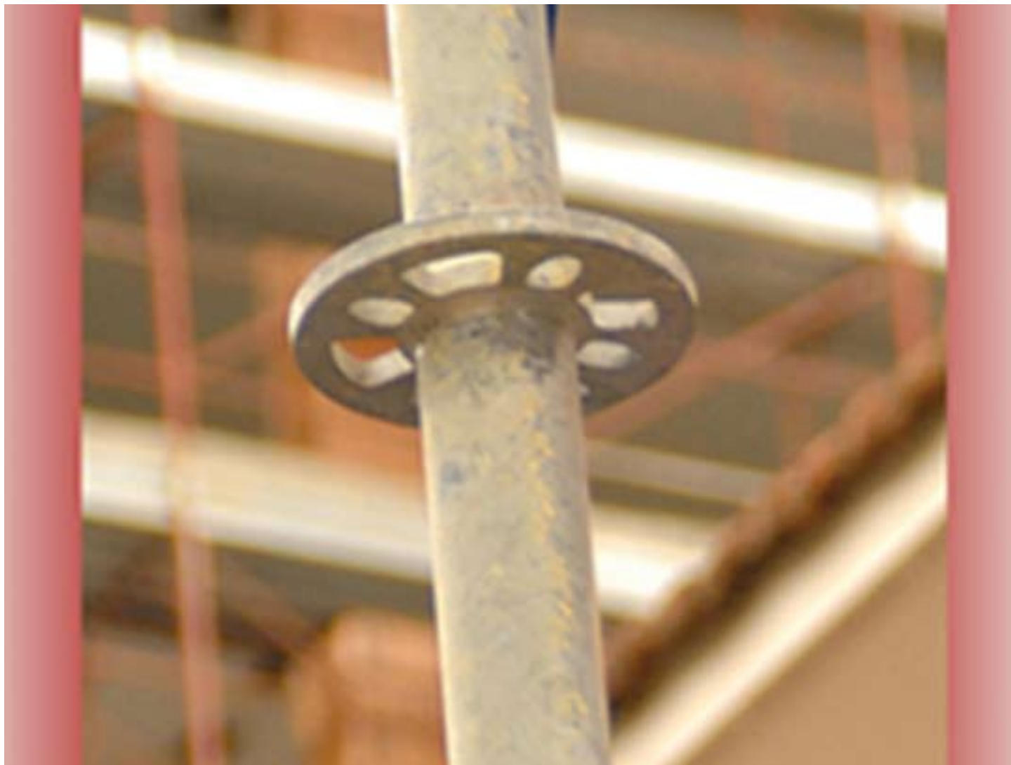
Fig. 2.3.1: “Piastra multidirezionale” a 8 fori del ponteggio a montanti e traversi prefabbricati (multidirezionale).
