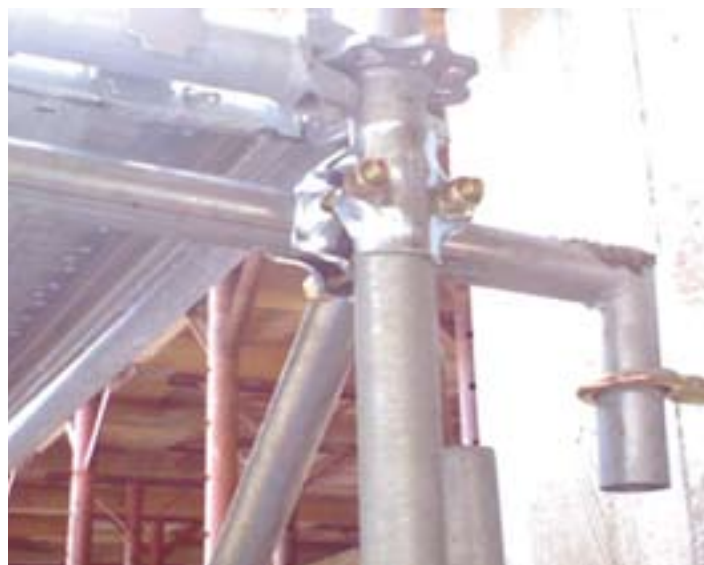
Fig. 4.4.10: Ancoraggio ad "L" autorizzato.
