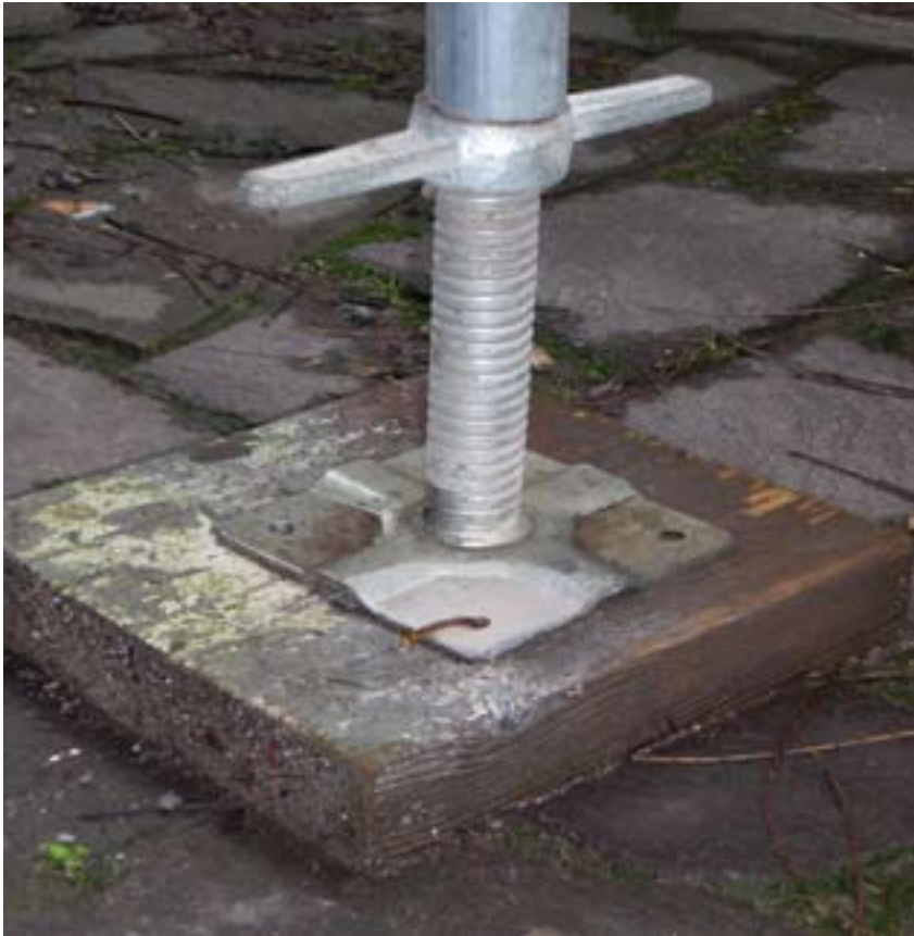
Fig. 4.1.3: Il libretto indica come elemento di ripartizione del carico una tavola di legno di spessore cm. 5; quindi le basette in plastica gialla, non essendo autorizzate, non sarebbero consentite. Tuttavia la Circolare n. 29/2010 specifica che gli elementi al di sotto delle basette devono essere adeguati ai carichi e non obbligatoriamente in uno specifico materiale, anche in base a quanto previsto nel P.I.M.U.S.
