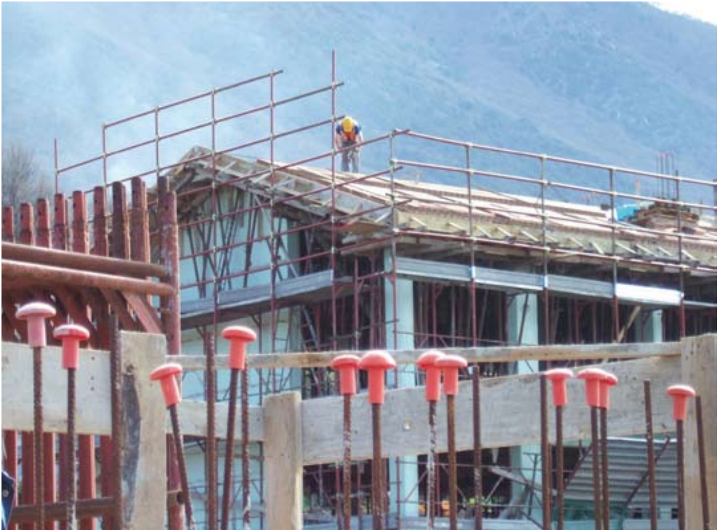
Fig. 4.5.1: Lavoro sul tetto inclinato; in questa situazione la protezione del lavoratore è costituita soltanto dal parapetto del ponteggio.
