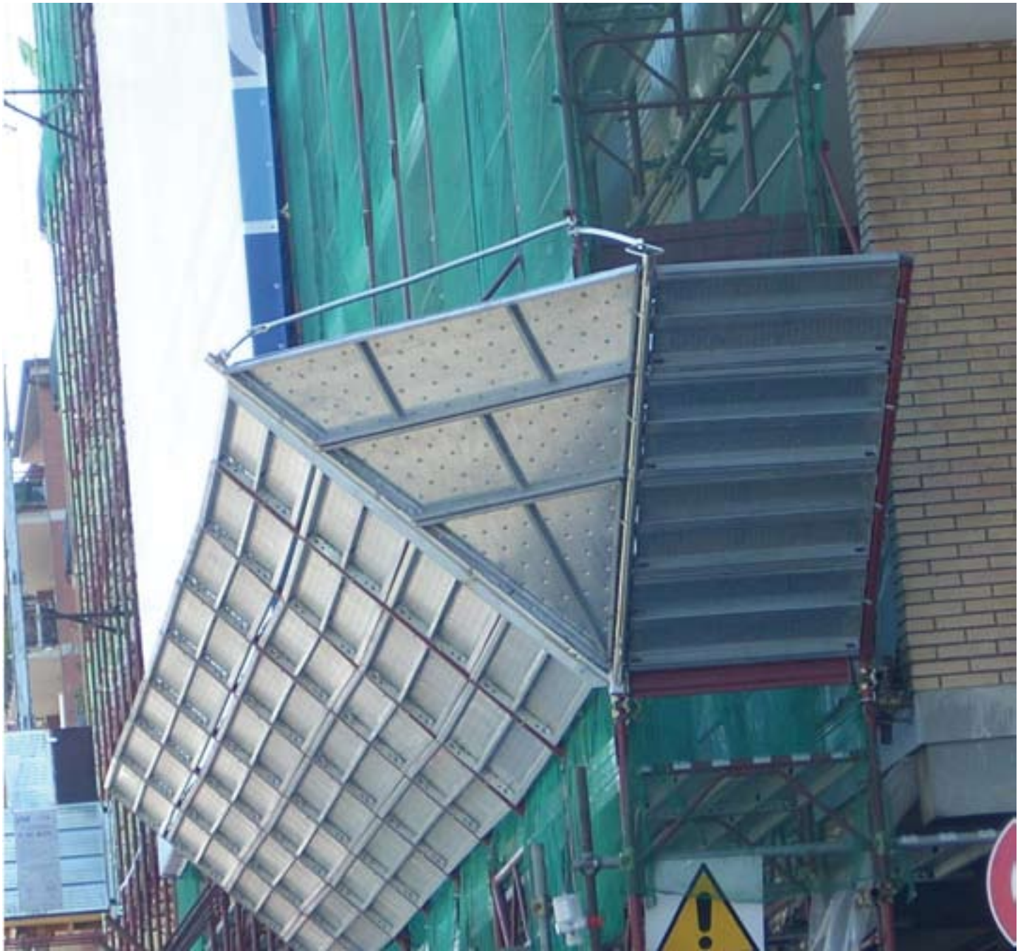
Fig. 4.3.9: Elementi metallici speciali per la realizzazione dell'angolo della mantovana.
