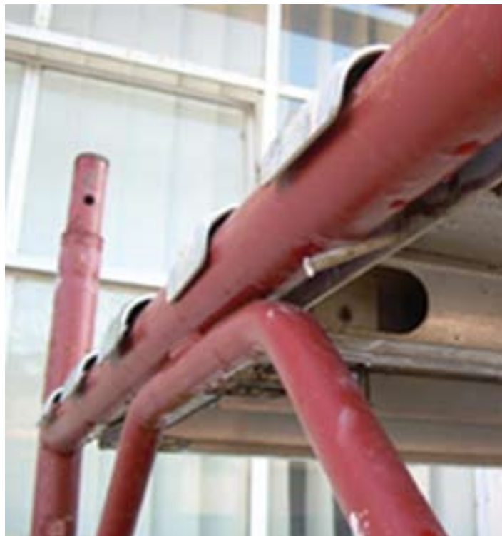
Fig 2.1. 2 - 2.1.3 : Archetto di irrigidimento.
