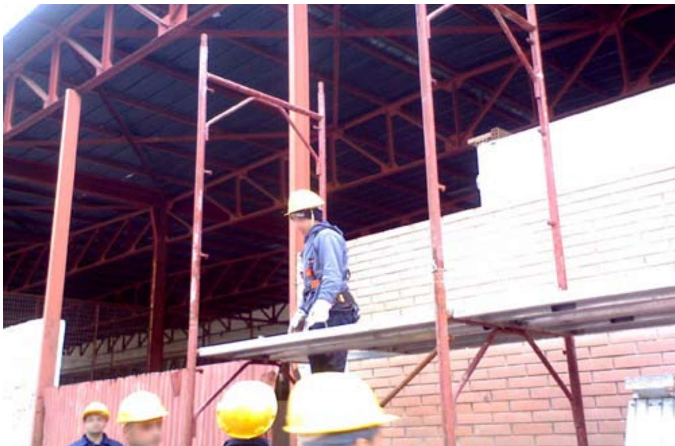
Fig. 6.3.11: Il telaio viene innestato.
