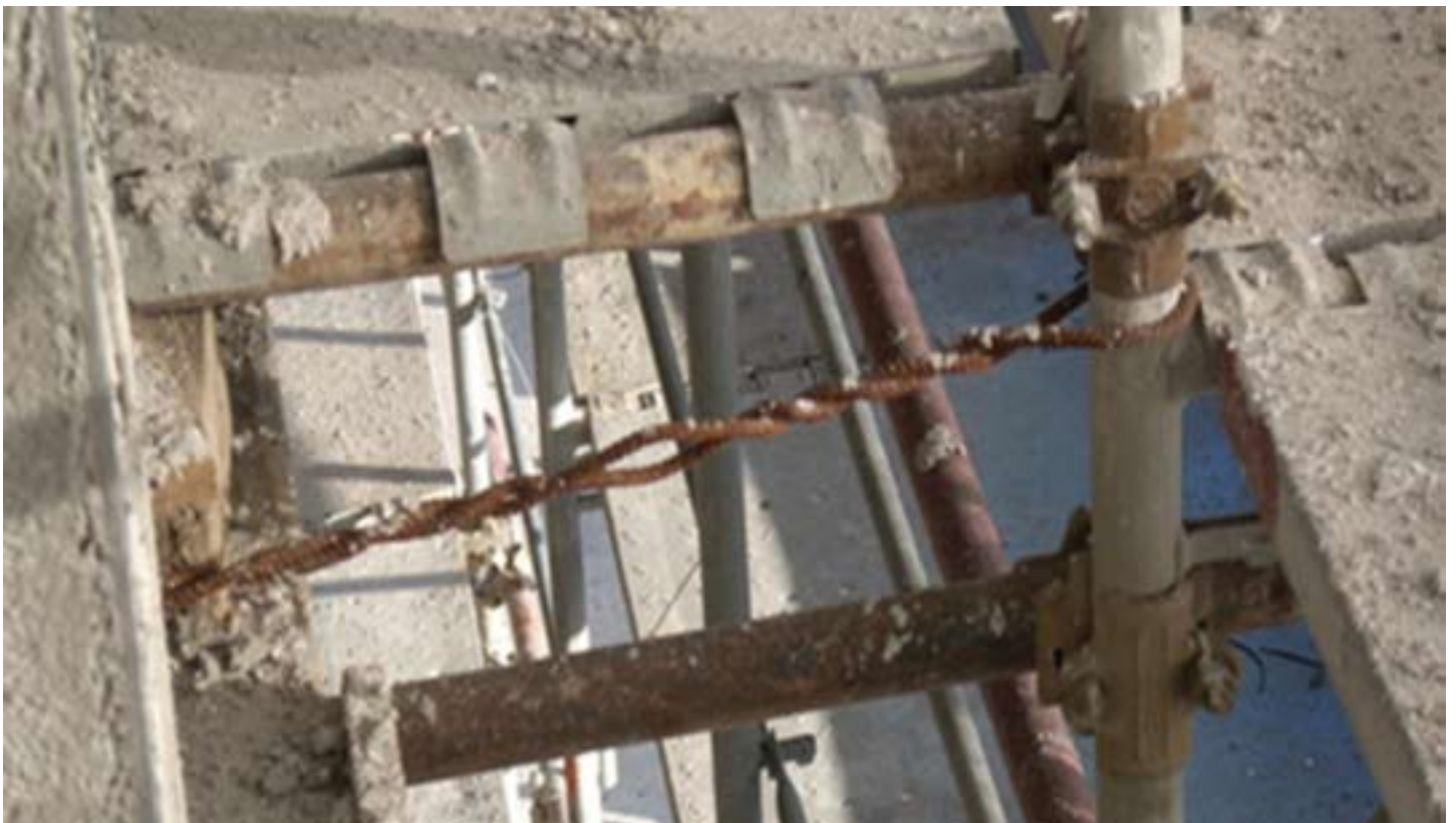
Fig. 4.4.6: Sono assolutamente vietati gli ancoraggi realizzati con filo di ferro ritorto.
