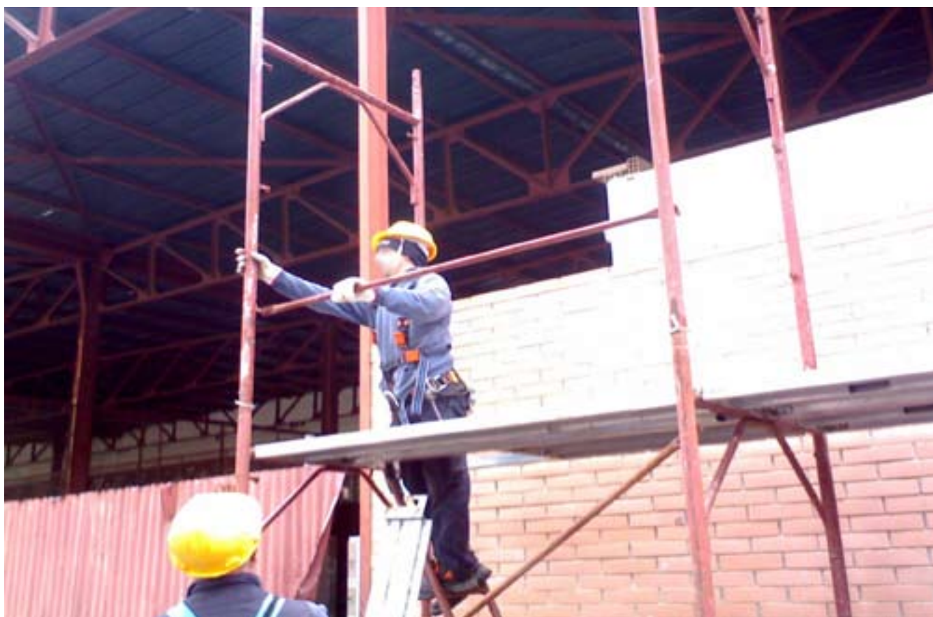
Fig. 6.3.12: Il lavoratore monta il primo dei due correnti parapetto.
