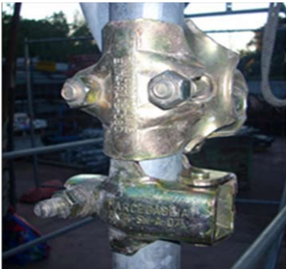
Fig. 2.2.3: Giunto ortogonale con il giunto di tenuta appartenente alla stessa autorizzazione ministeriale.
