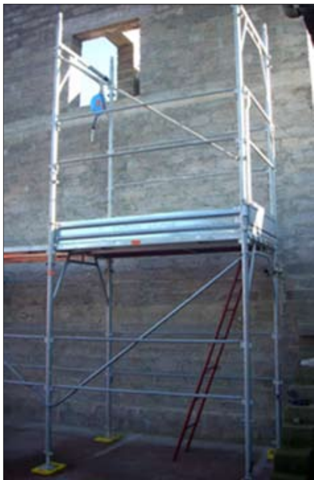
Fig. 1.3.1: Campata di ponteggio irrigidita con correnti parapetto e diagonale longitudinalmente e con tavola metallica trasversalmente
