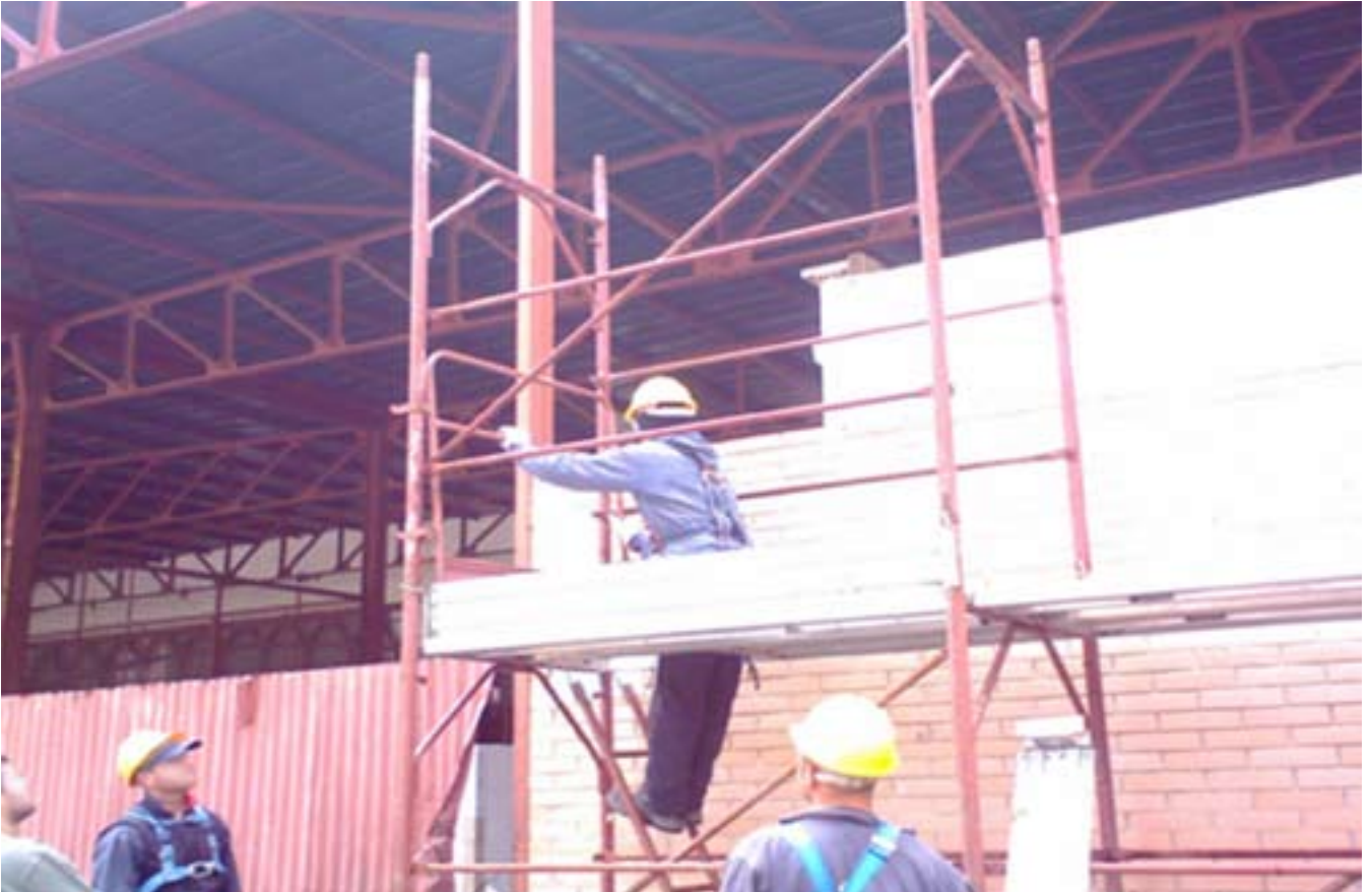
Fig. 6.3.15: Sempre rimanendo sulla scaletta monta il cancelletto di testata.
