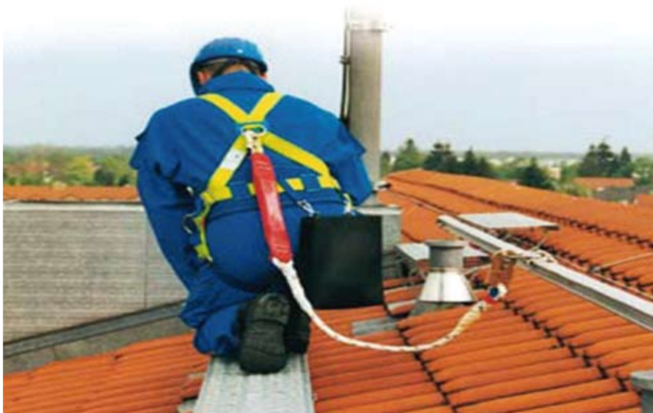
Figg. 4.5.4 e 4.5.5: Sistemi di arresto di caduta per lavoratori che operano su tetti a falda inclinata.
