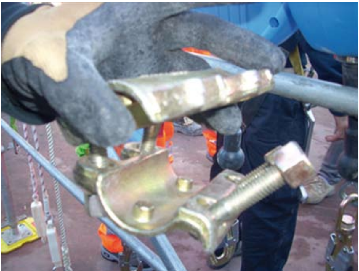
Fig. 2.2.9 - 2.2.10: Inserimento dei perni nei fori.
