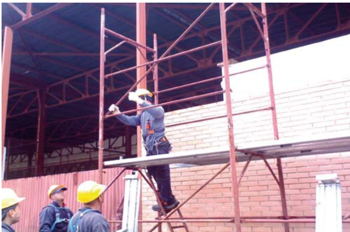
Fig. 6.3.14: Quindi monta la diagonale di facciata.
