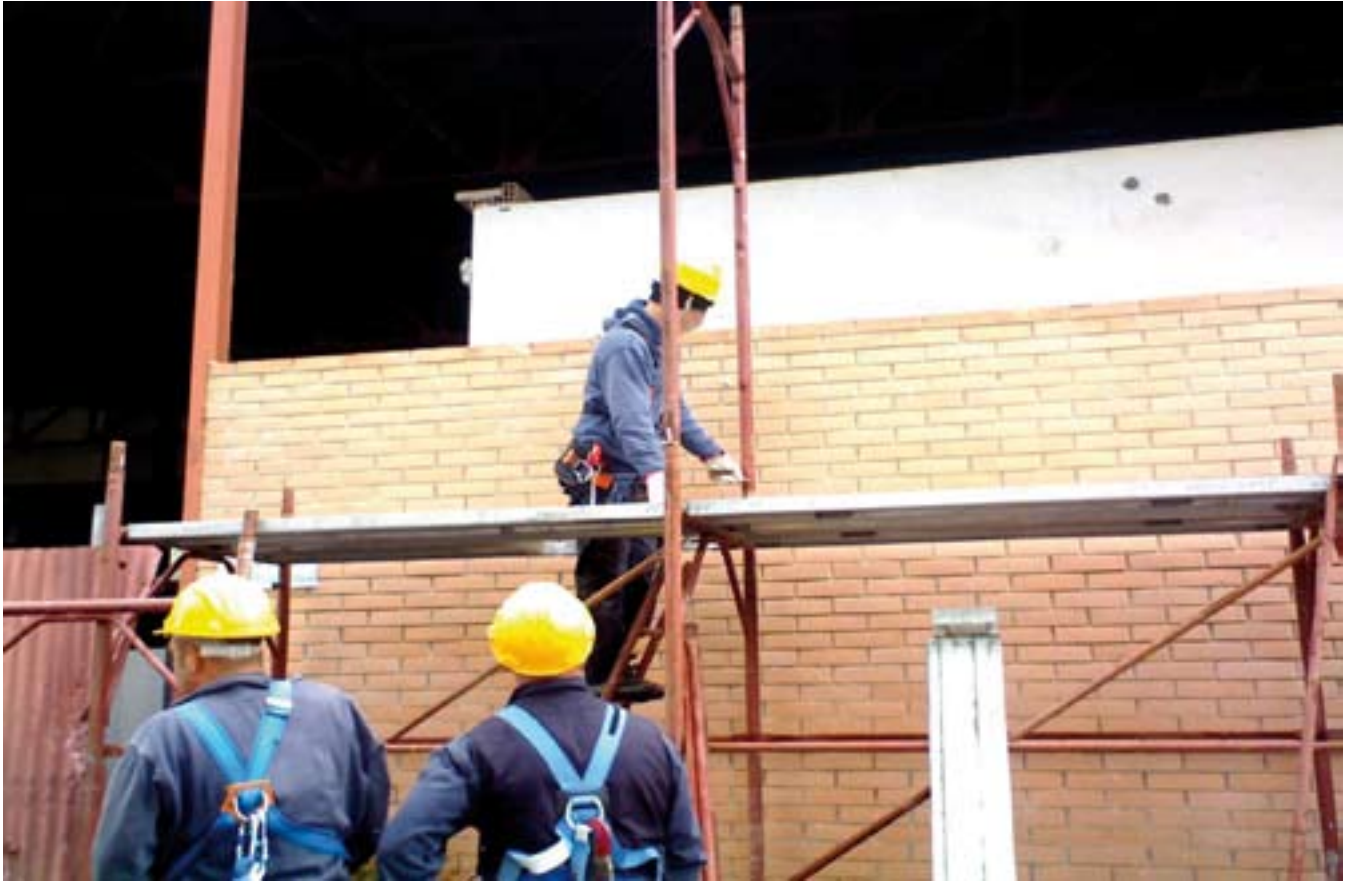
Fig. 6.3.7: Il lavoratore mette le spine a verme per bloccare il telaio.
