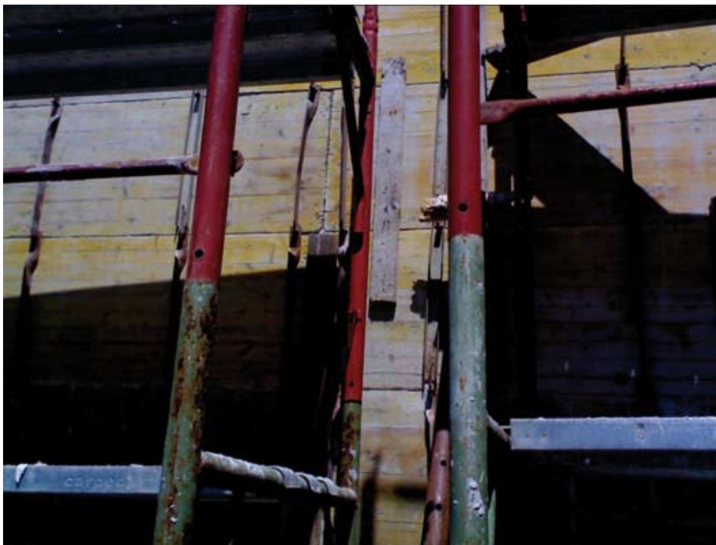
Fig. 3.1: Non è consentito utilizzare insieme elementi di ponteggio a telaio prefabbricato appartenenti ad autorizzazioni ministeriali diverse.
