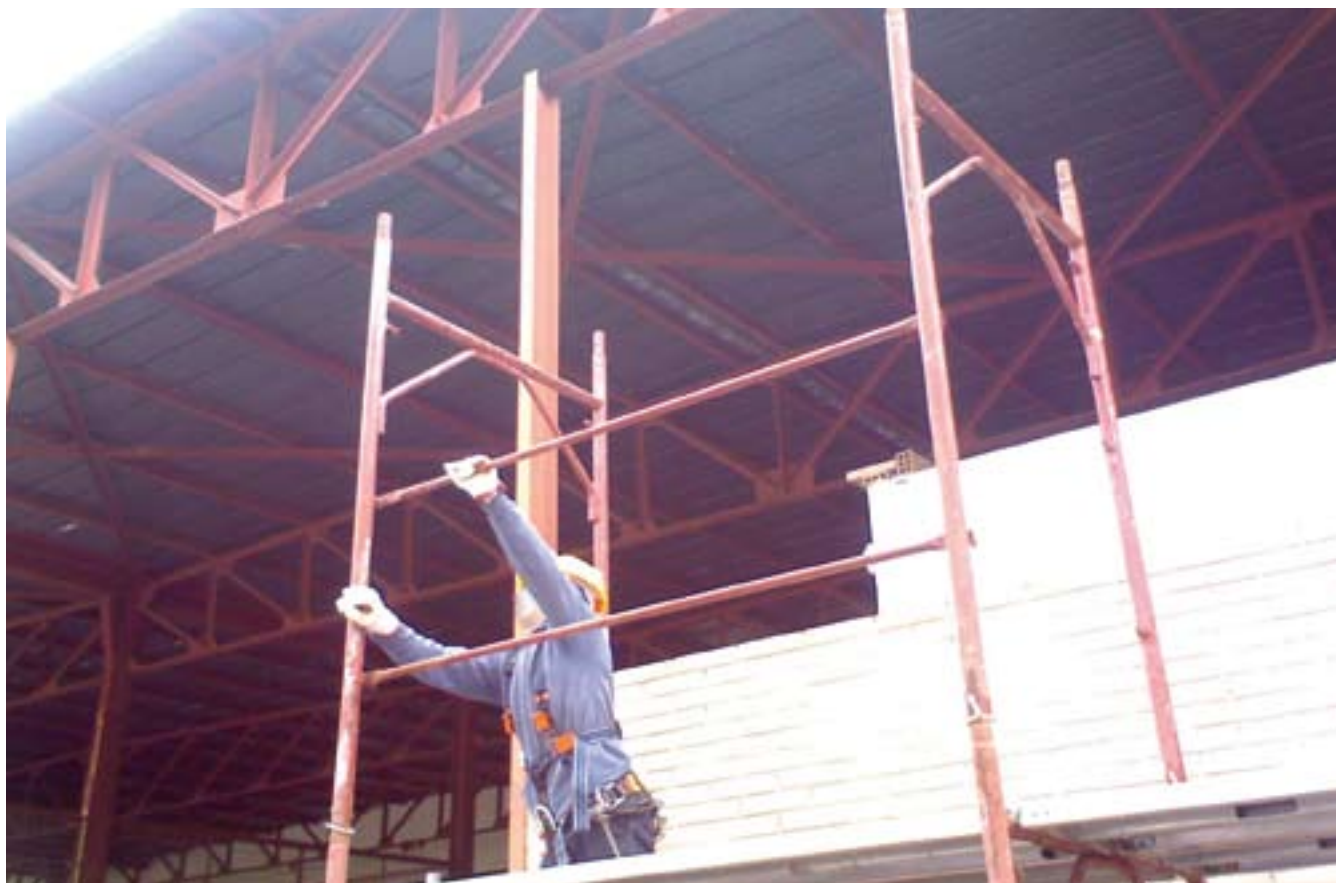
Fig. 6.3.13: Il lavoratore monta il secondo corrente parapetto sempre rimanendo sulla scaletta.
