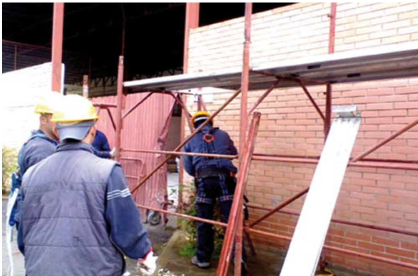
Fig. 6.3.9: Il lavoratore sale fino a metà scaletta.
