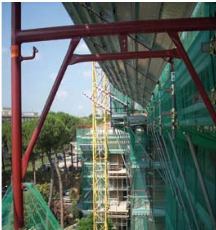
Fig 2.1. 2 - 2.1.3 : Archetto di irrigidimento.
