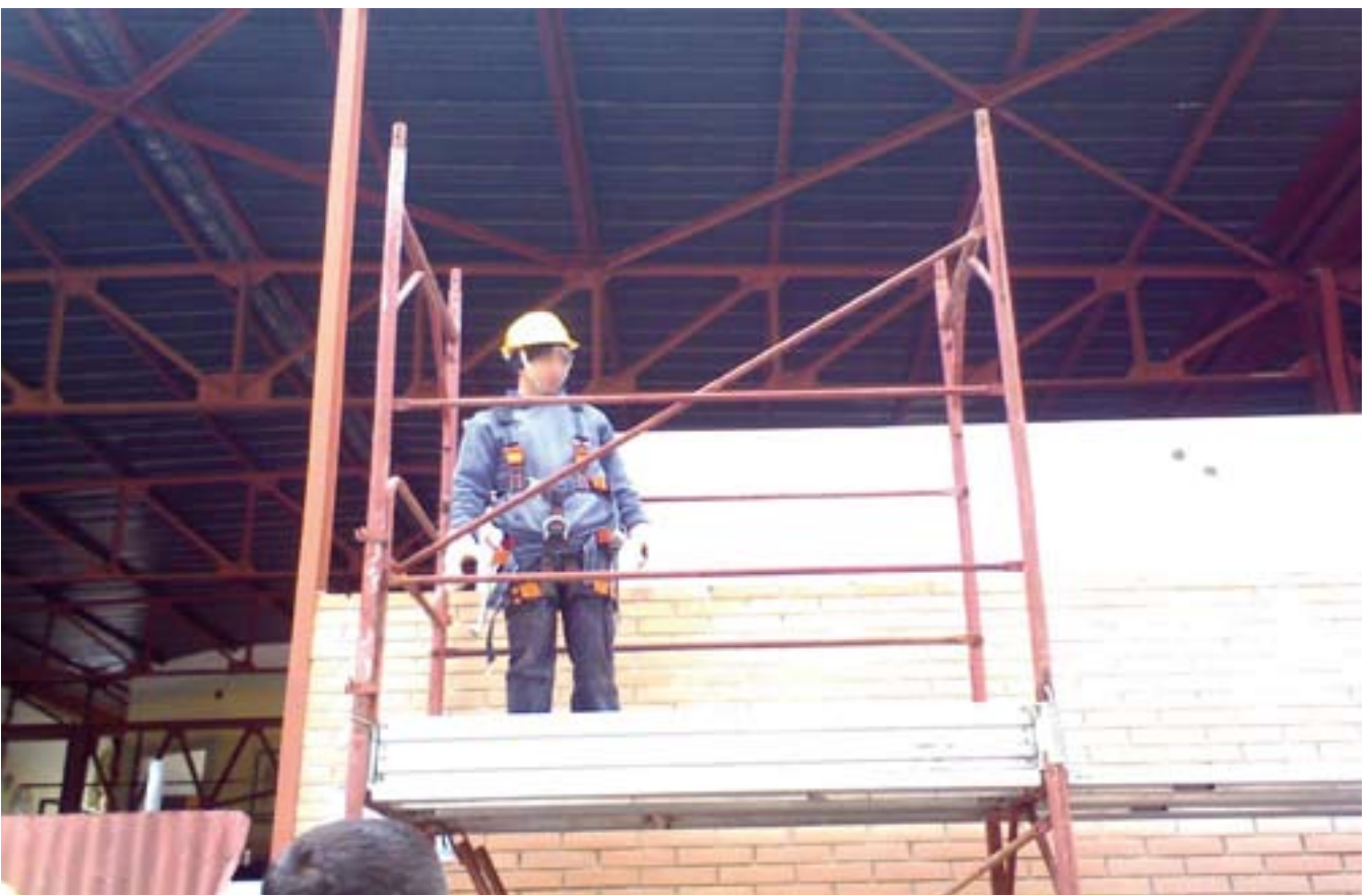
Fig. 6.3.16: Ora può salire perché si trova in un campo protetto.
