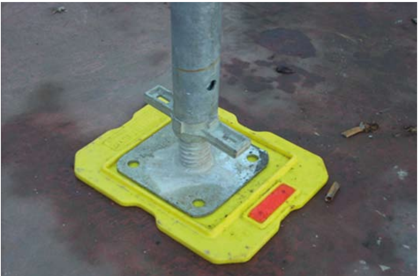
Fig. 4.1.4: Elemento di ripartizione del carico non presente nel libretto di autorizzazione ministeriale.
