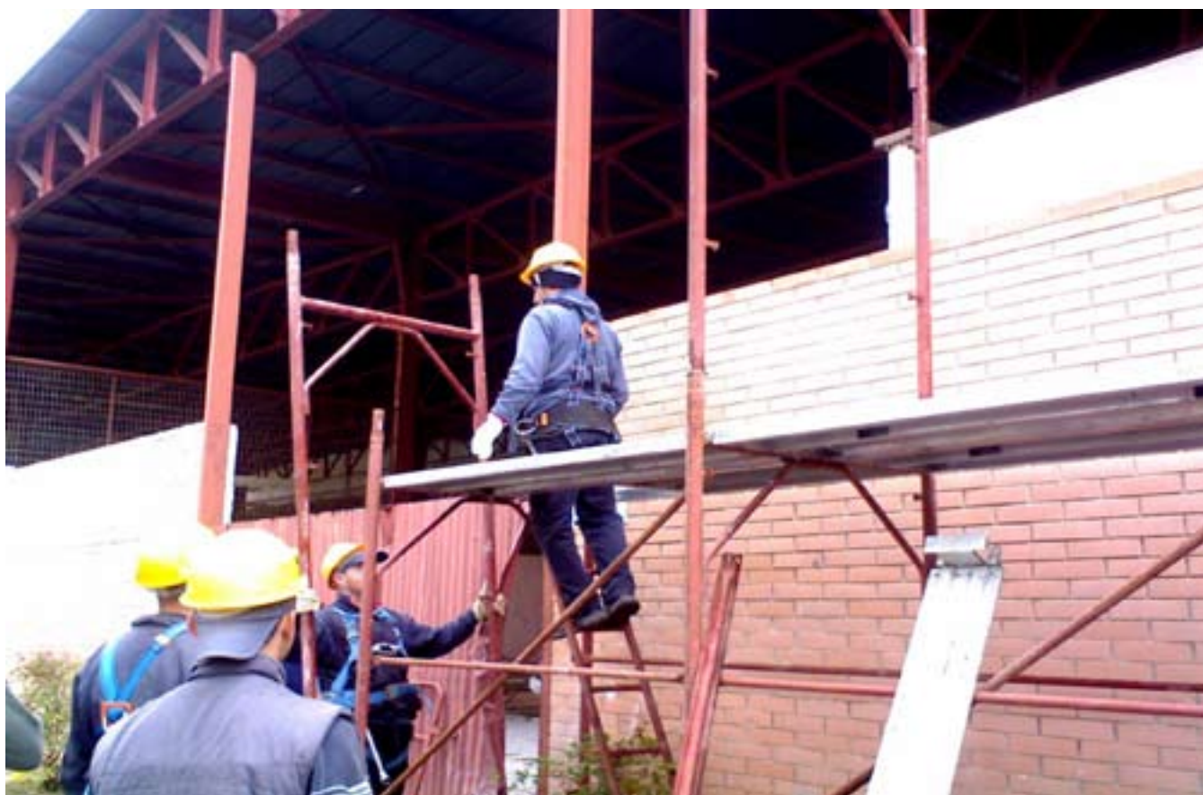
Fig. 6.3.10: Prende il telaio dalla testata del ponteggio.
