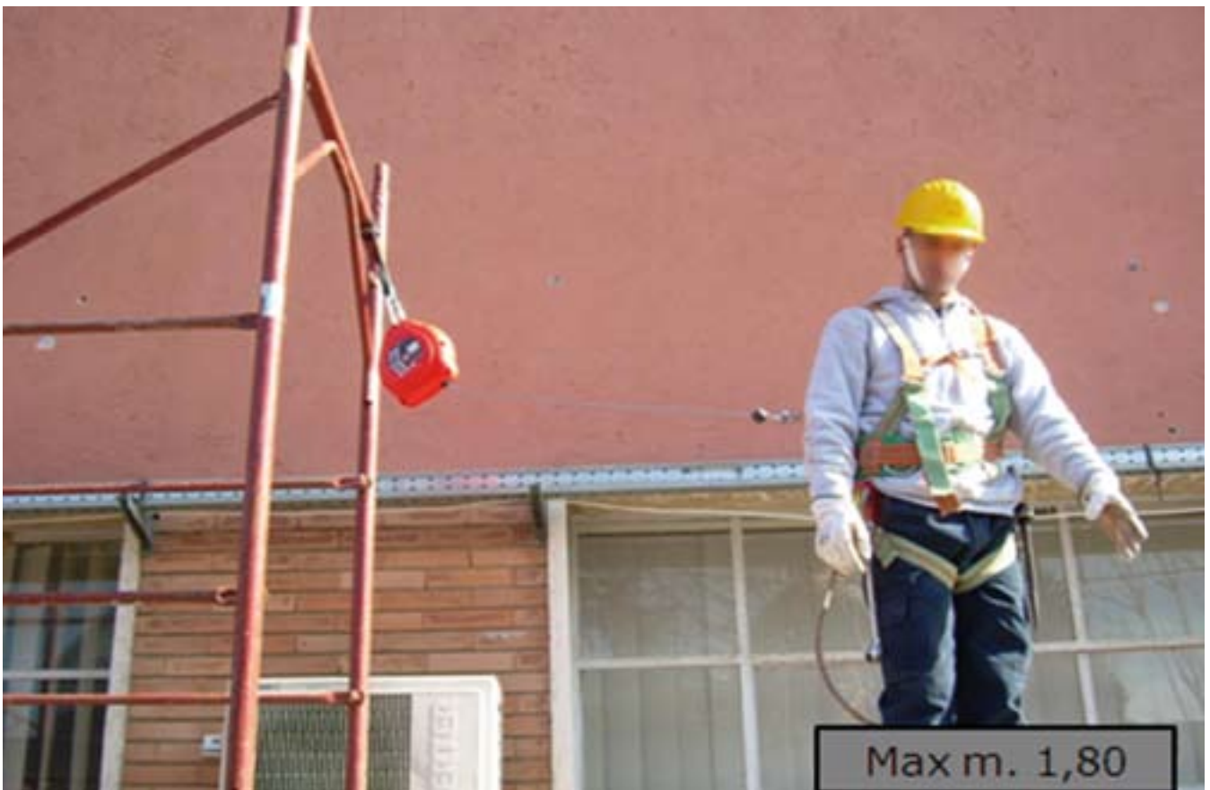
Fig. 6.3.20: Non si deve mai spostare oltre la campata successiva...
