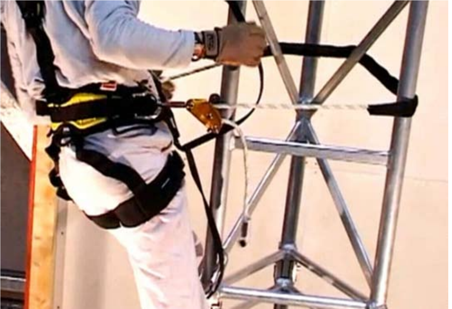
Fig. 7.4: Cordini di posizionamento collegato tramite gli anelli a D alla cintura di posizionamento.
