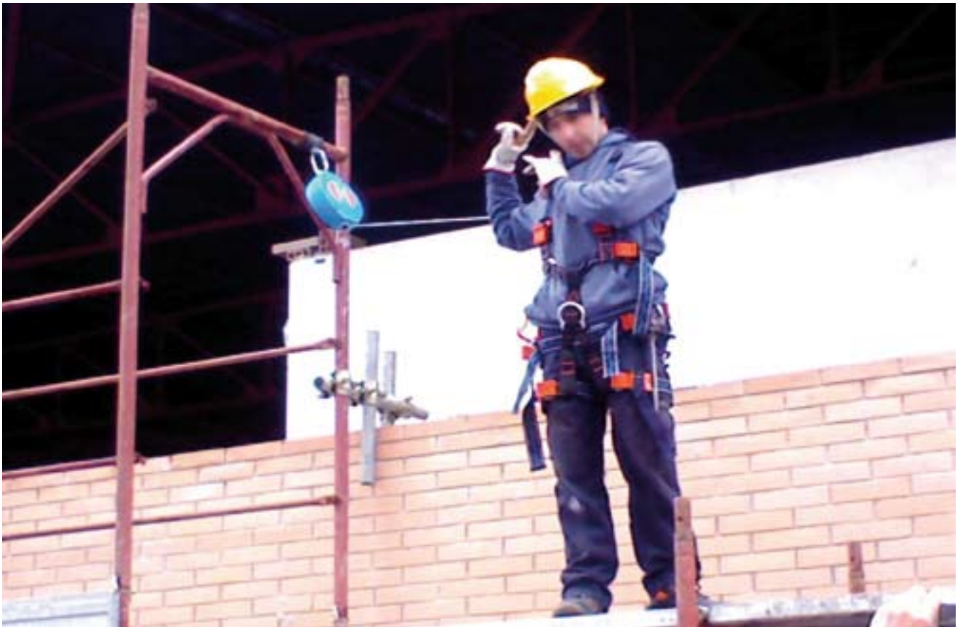
Fig. 6.3.19: Ora può iniziare a montare la campata successiva...
