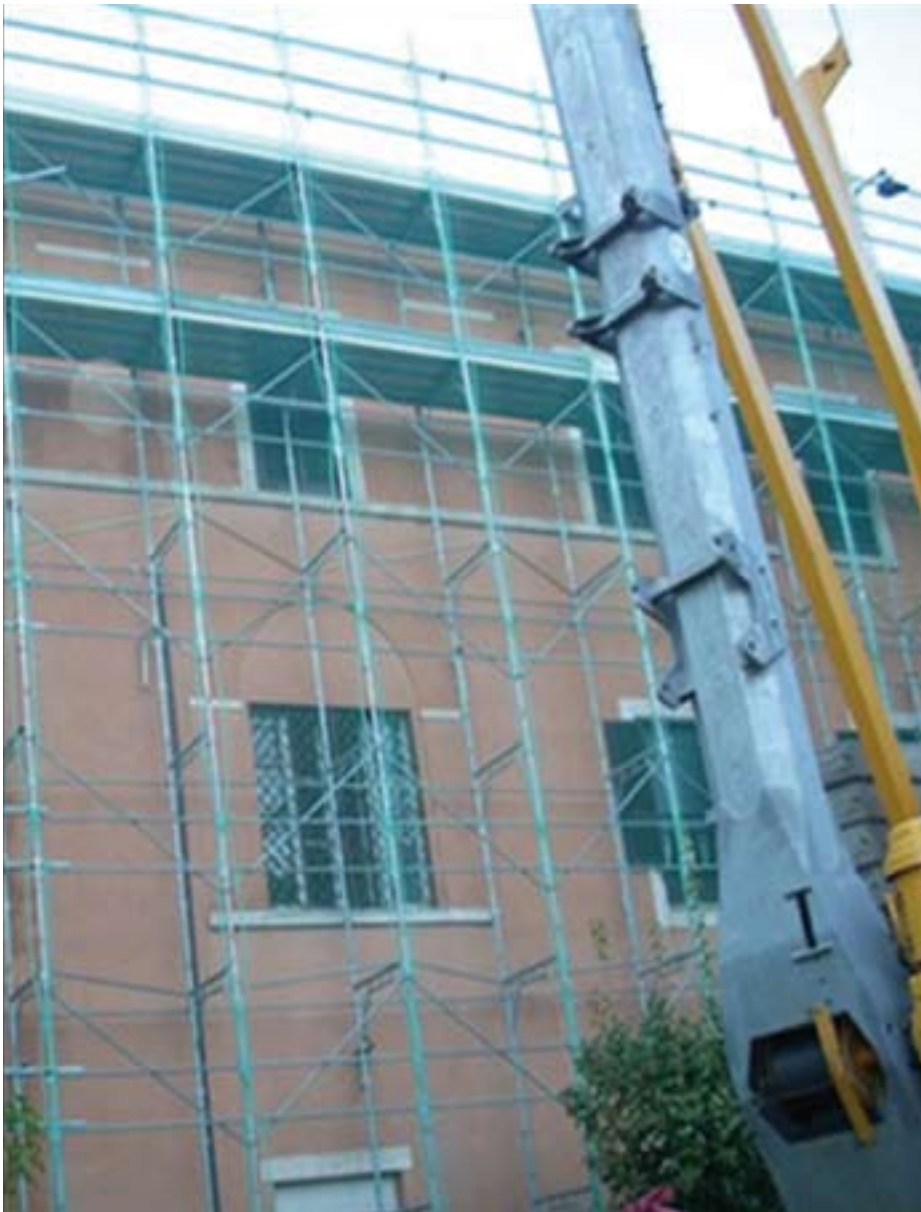
Fig. 4.2.1: Il ponteggio prevede un unico piano per l'esecuzione di lavori sul cornicione dell'edificio, con il sottoponte di sicurezza che non può essere usato come piano di lavoro. Da notare che i piani privi di tavole sono irrigiditi a piani alterni dal corrente interno e dalla diagonale in pianta.
