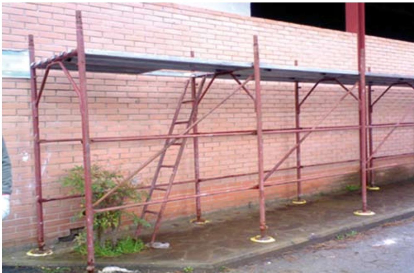
Fig. 6.3.5: Il primo impalcato del ponteggio è stato montato
