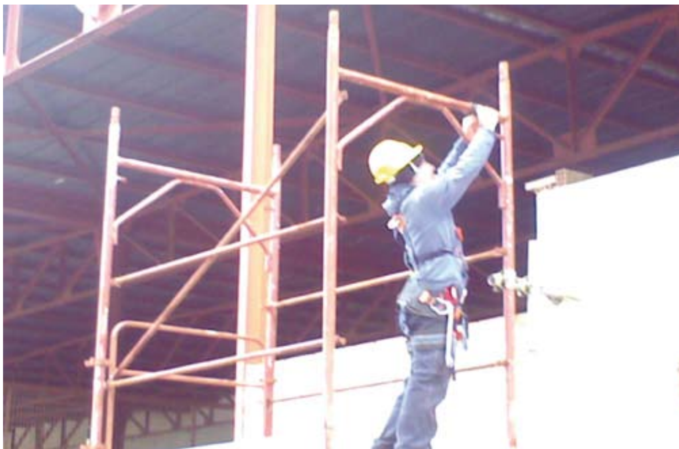
Fig. 6.3.17 : Rimanendo all'interno della campata, il lavoratore esegue un nodo semplice o doppio con il dispositivo di ancoraggio tessile UNI EN 795 classe b.
