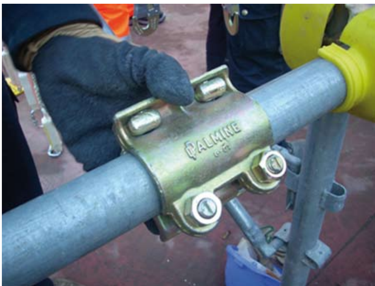
Fig. 2.2.11 - 2.2.12: Montaggio del giunto.
