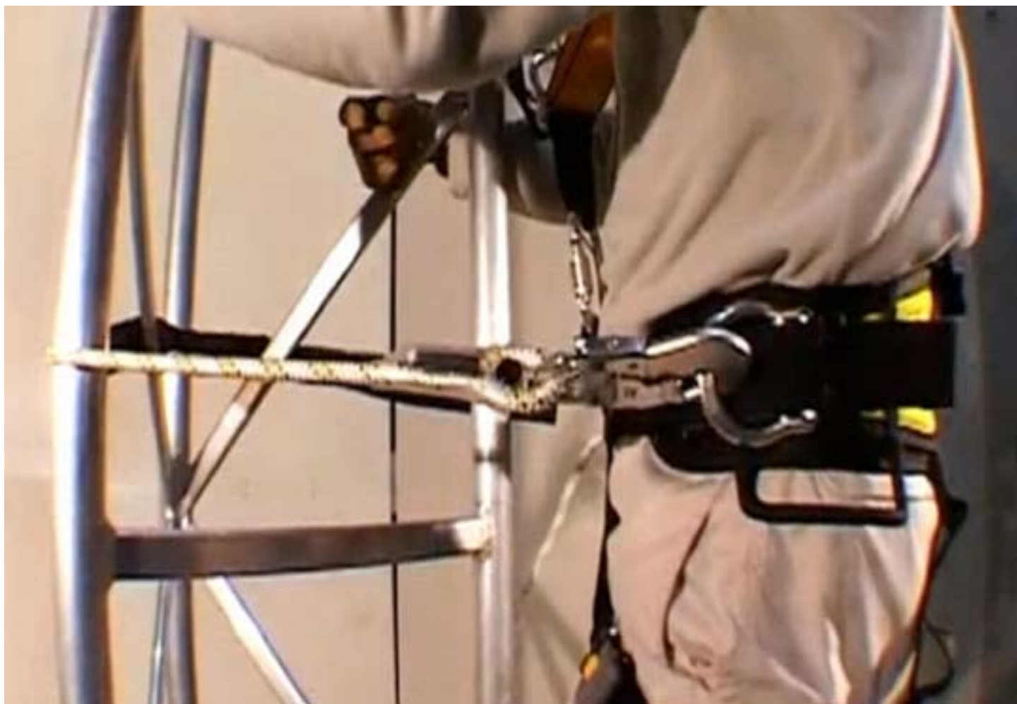
Fig. 7.6: La cintura di posizionamento ha due anelli a D, sui quali viene collegato, tramite connettori, il cordino di posizionamento; entrambi devono essere conformi alla norma armonizzata UNI EN 358; altri cordini, che possono essere usati per il posizionamento, sono indicati nella norma UNI EN 354. Entrambi sono privi di dissipatore di energia.
