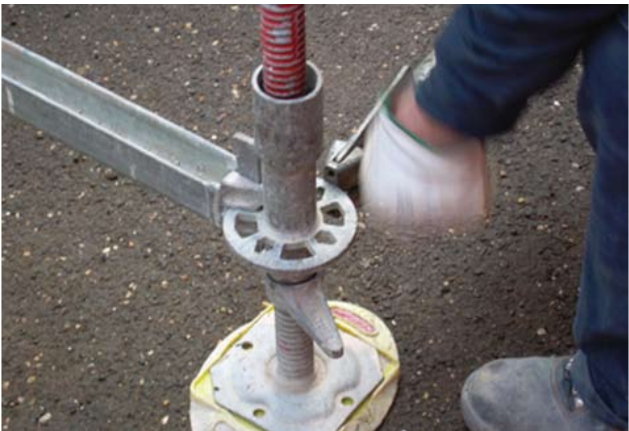
Fig. 2.3.4: Il cuneo viene inserito nel foro della piastra multidirezionale.
