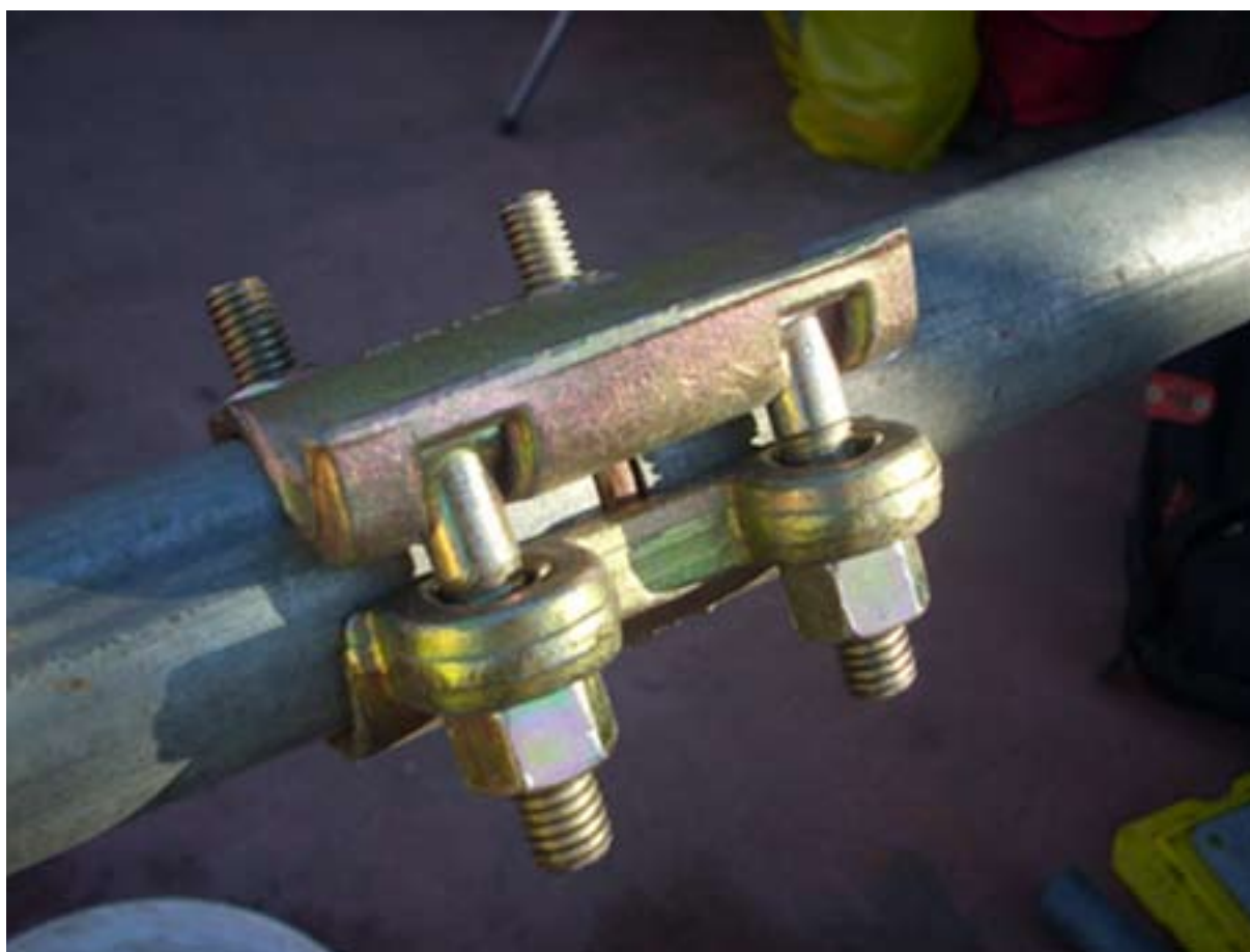
Fig. 2.2.15 - 2.2.16: Serraggio del giunto.
