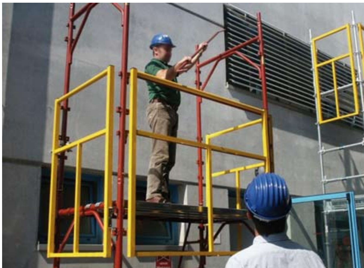
Fig. 6.1.2: Parapetto provvisorio appartenente all'autorizzazione ministeriale e utilizzabile quindi solo con una determinata marca e tipo di ponteggio. Una volta montato dal piano inferiore a protezione dei lavoratori, questi dovranno montare il parapetto definitivo.
