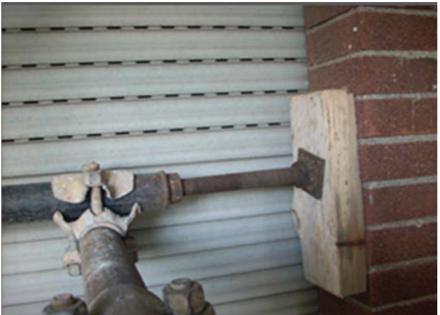
Fig. 4.4.15: Ancoraggio a vitone realizzato con asta estensibile a contrasto tra le spallette di una finestra.
