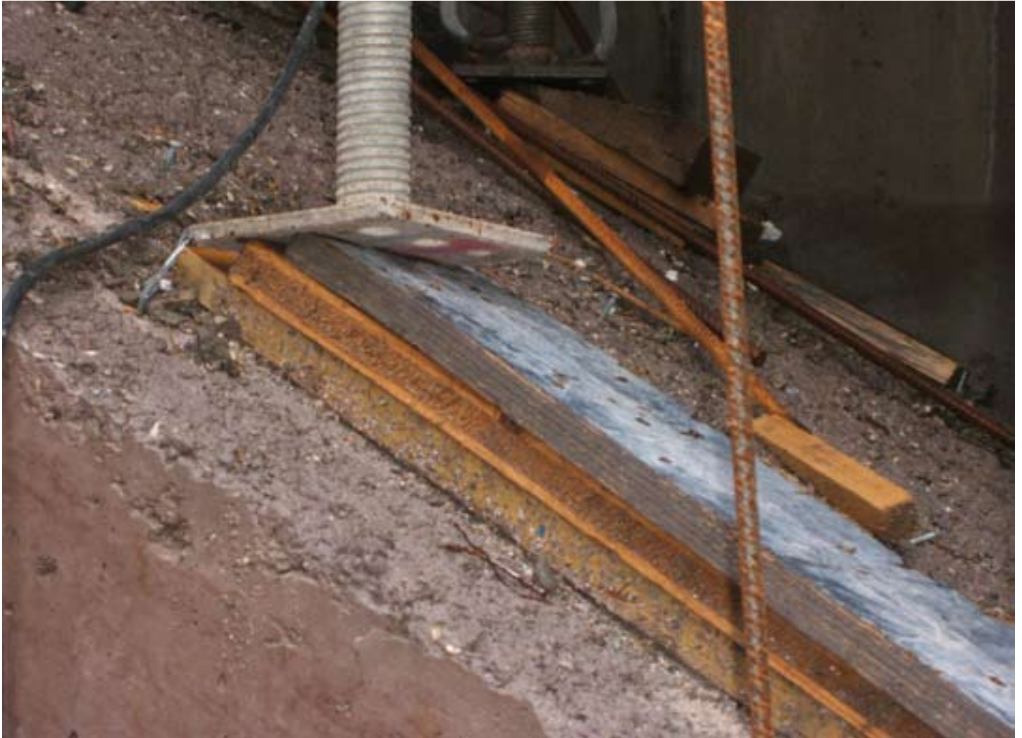
Fig. 4.1.5: Basetta su piano inclinato.
