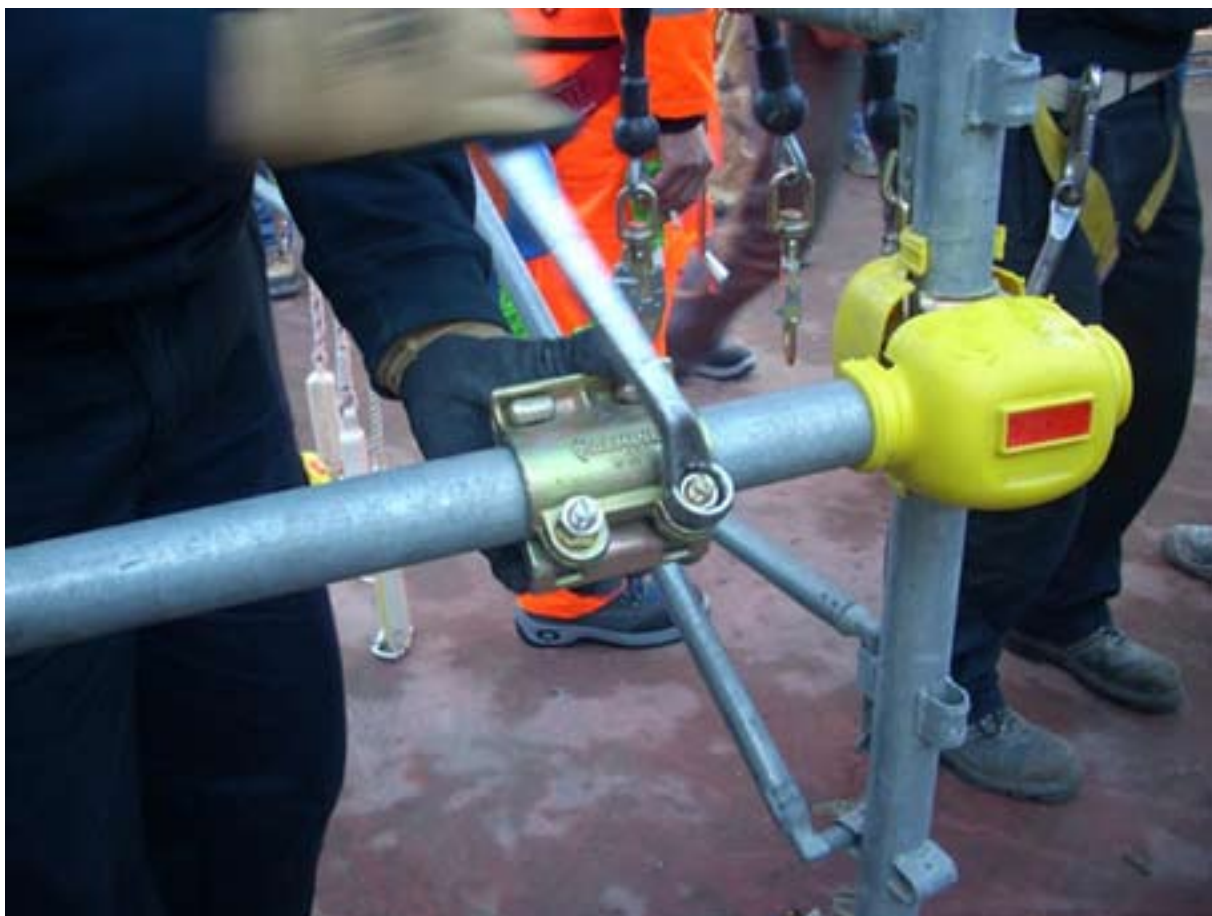
Fig. 2.2.13 - 2.2.14: Serraggio del giunto.
