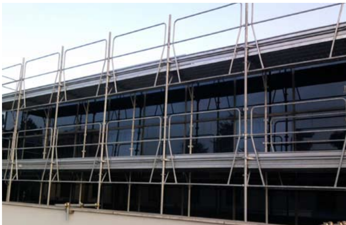
Fig. 6.1.3: Parapetto definitivo montabile dal basso. Con questo ponteggio i lavoratori non usano Dpi anticaduta per montare il ponteggio
