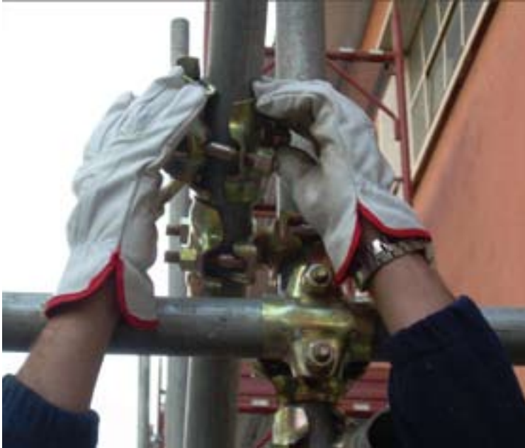
Fig 2.2.1: Ponteggio a tubi e giunti.
